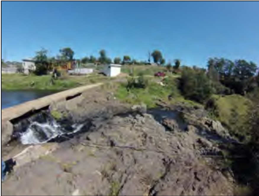
Figure 4.17 Seuil de retenue d'eau sur la rivière Naolinco pour le soutirage de l'eau
