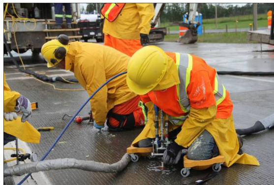
Figure 1.18 Méthode d'injection du PU pour le rehaussement de la chaussée Tirée de (Yu, Wang et Skirrow, 2013) p.6
