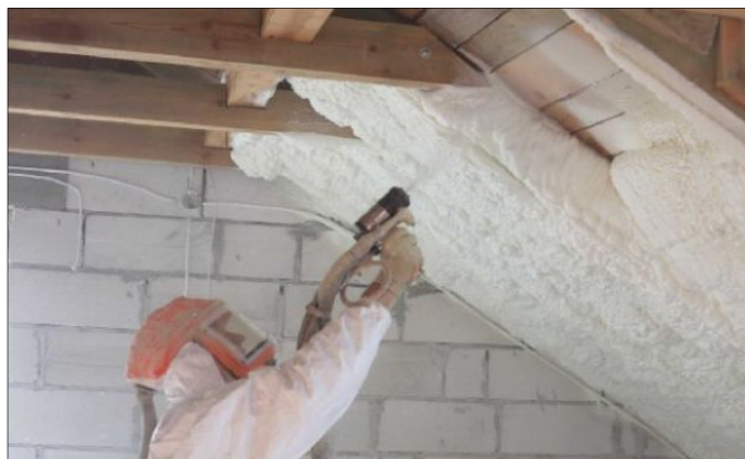
Figure 1.14 Isolation par projection de mousse PU Tirée de (Kristof, 2013)
