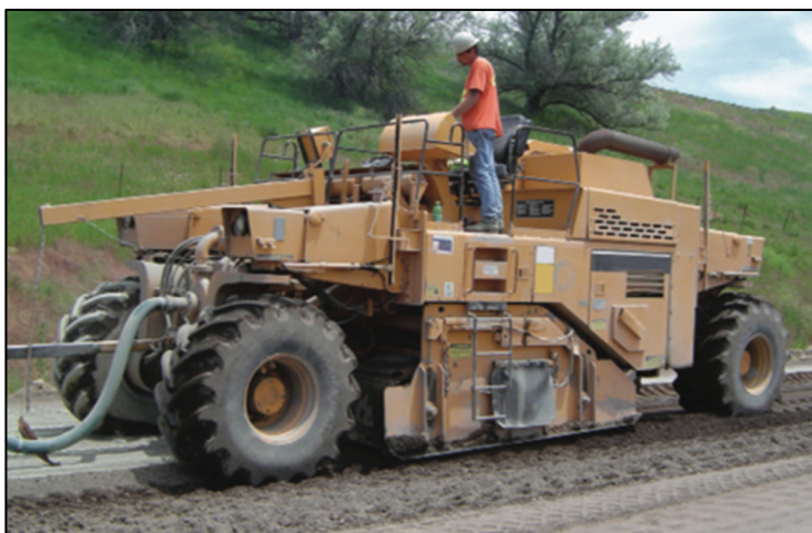
Figure 1.23 Malaxage et injection (Halsted, Luhr et Adaska, 2006)
