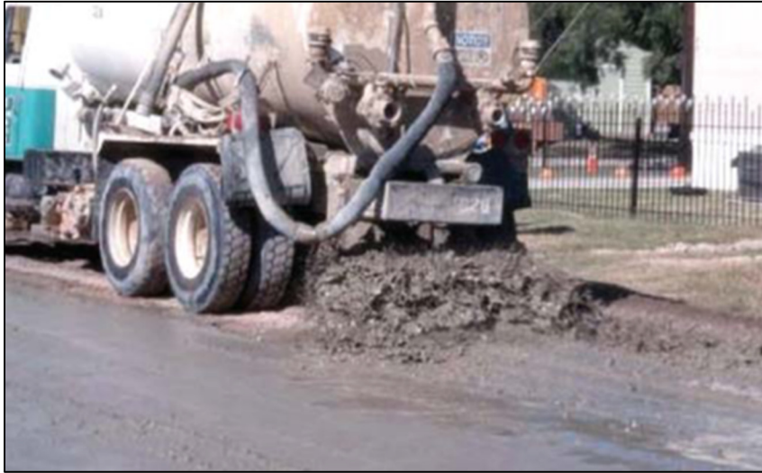
Figure 1.20 Épandage du ciment par voie humide (laitance) (Luhr, Adaska et Halsted, 2005)
