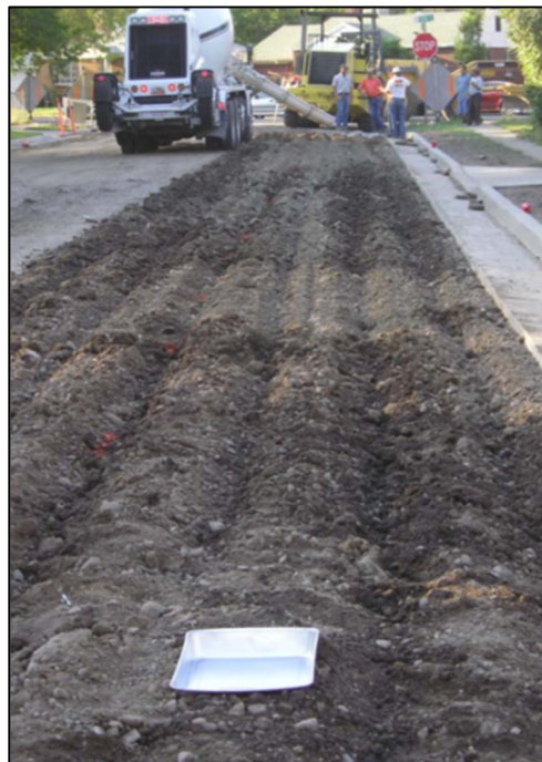
Figure 1.21 Mesure du taux d'épandage du ciment (Hope, 2011)
