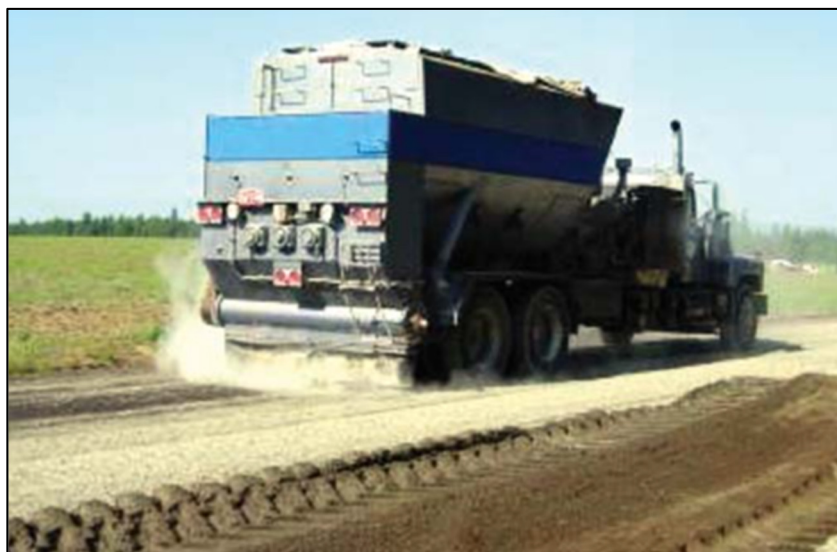
Figure 1.19 Épandage du ciment par voie sèche (Luhr, Adaska et Halsted, 2005)
