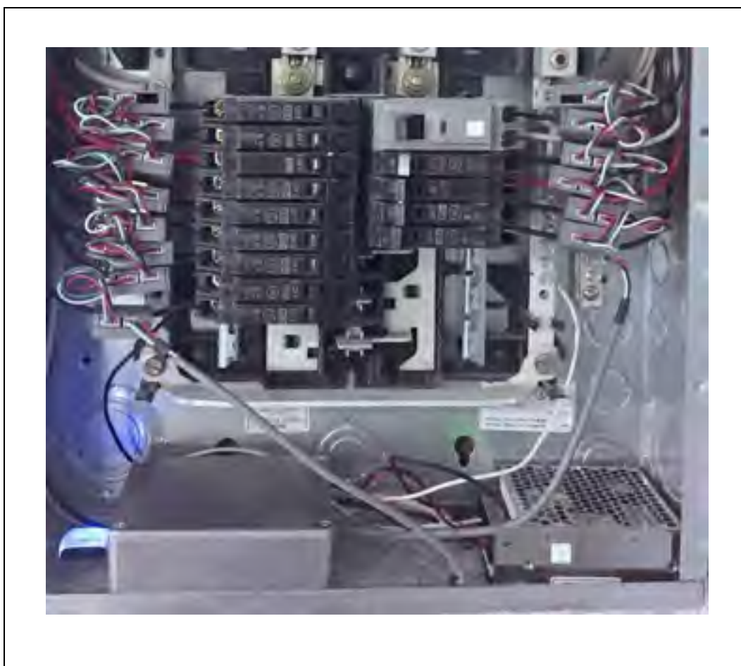
Figure 1.13 Installation de 14 capteurs HES avec l'UCT dans une boîte électrique
