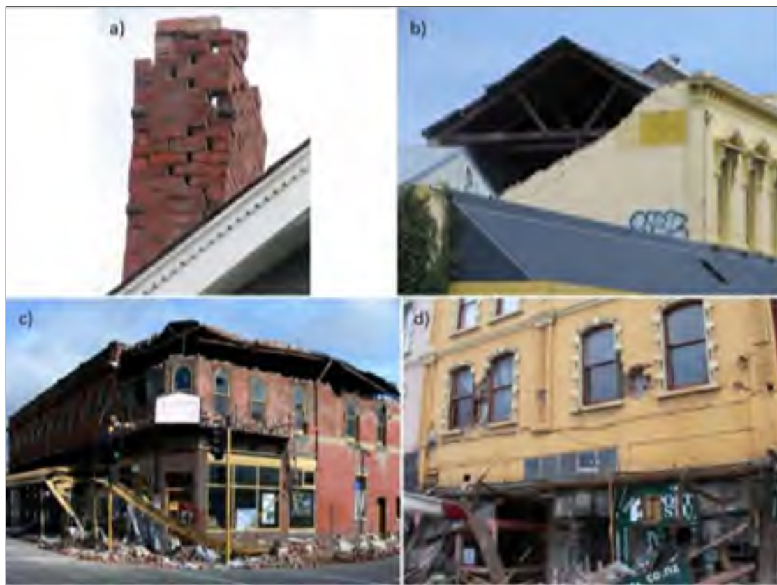
Figure 1.4 Exemple de rupture de différents bâtiments en MNA : a) Cheminée instable, b) Pignon effondré, c) Parapet effondré et d) Rupture en poinçonnement au niveau des ancrages du mur Tirée de Ingham (2011)
