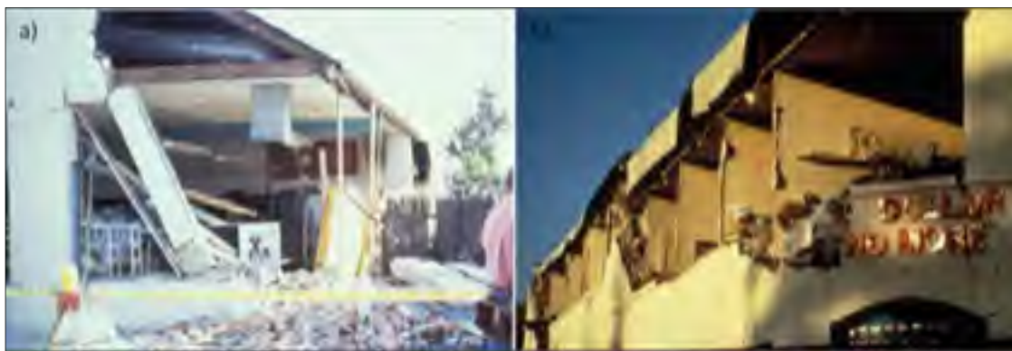
Figure 1.5 Dommages sur des bâtiments en maçonnerie : a) Rupture d'un mur extérieur et b) Rupture de mur extérieur d'un deuxième étage Tirée de Klingner (2006)
