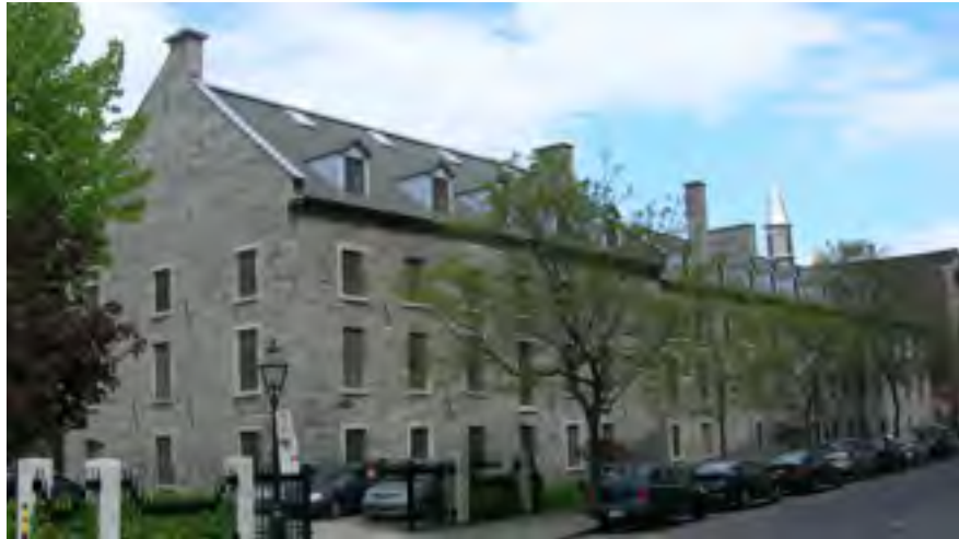
Figure I.1: Ancien hôpital général de Montréal
