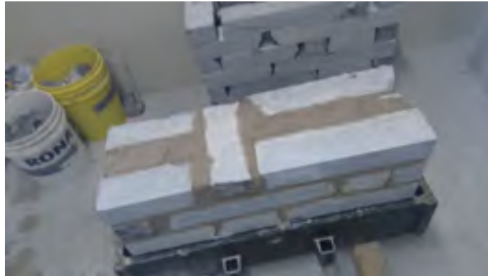
Figure 1.2 Mur en MNA de pierre traditionnelle en construction
