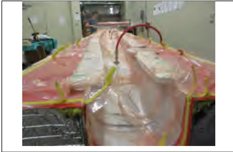
Figure 5.6 Mise sous vide du stratifié de coque
