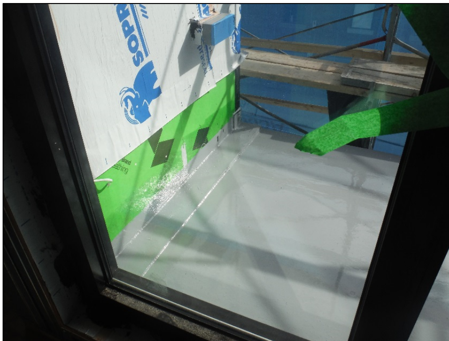
Figure 4.15 Arbora 1 - Dalle de balcon préfabriquée avec intégration des pentes
