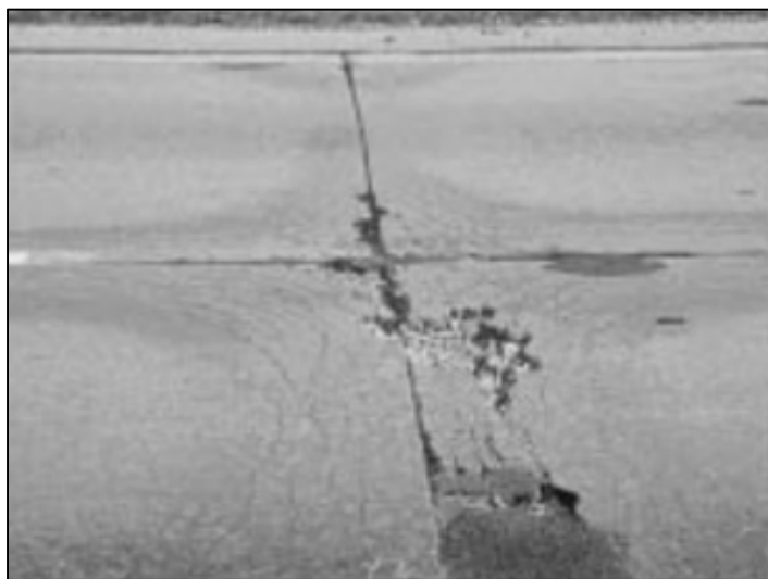
Figure 1-12 Trésaillure dans les chaussées en béton Tirée de Pigeon & Pleau (1995)
