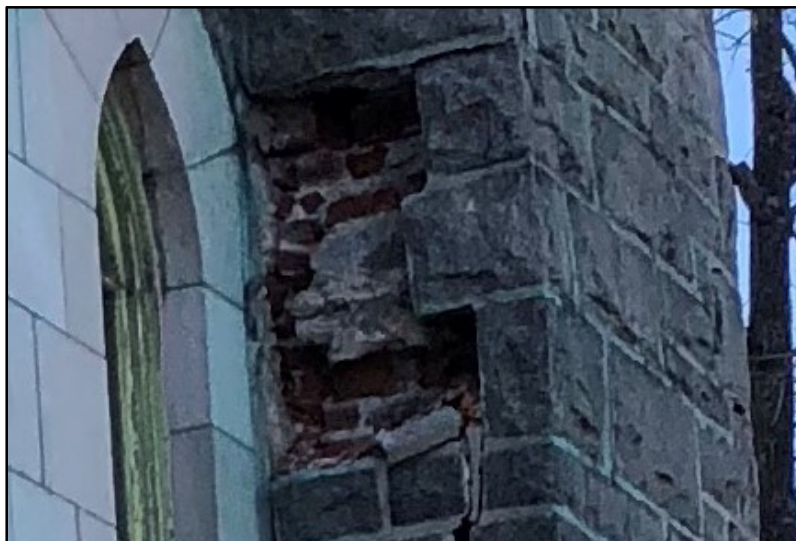
Figure 1.6 Église Saint Arsène, MNA de brique servant de remplissage derrière un parement de MNA de pierre
