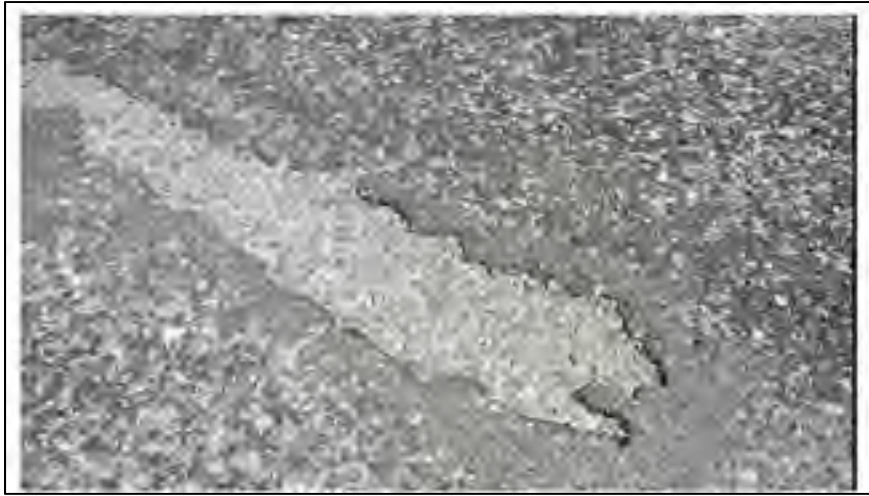
Figure 1.27 Décohésion typique d'un traitement de surface Tirée de Adams (2014)
