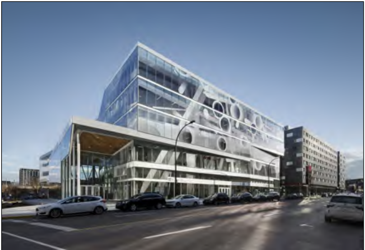
Figure 2.1 Bâtiment de la Maison des Étudiants de l'ETS
