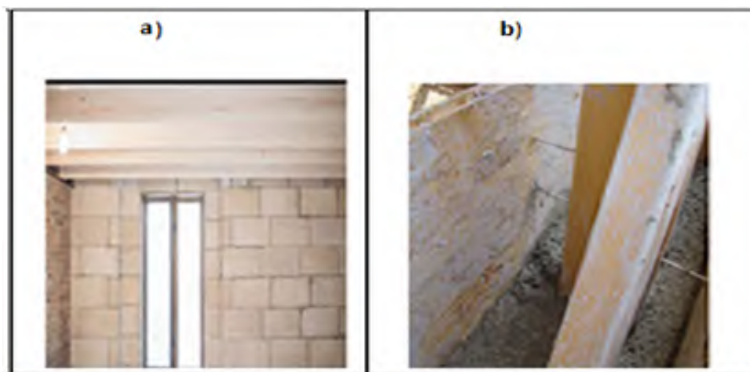
Figure 1.28 Mur en brique de chanvre (a) et mortier de chanvre projeté (b) Tirée de Pronovost (2017)
