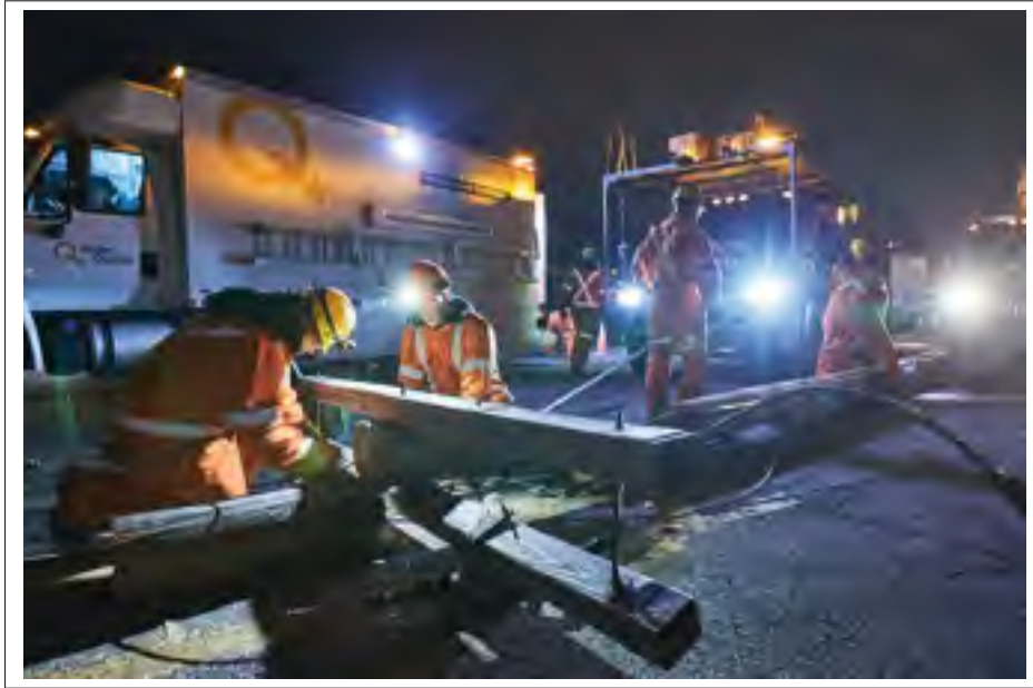
Figure 0.1 Panne électrique résultant de forts vents au Québec. Tirée de Hydro-Québec (2019, p. 1)
