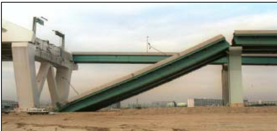
Figure 1.5 Déchaussement d'une travée simplement appuyée Tirée de Mark et al. (2014)
