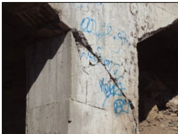
Figure 1.9 Rupture en cisaillement du béton Tirée de Mitchell et al. (2013)
