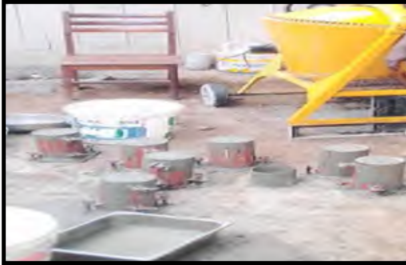
Figure 3-8 Image montrant la production du béton hydraulique
