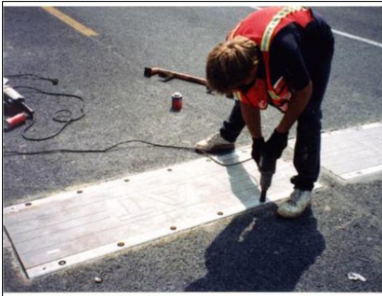
Figure 3.18 Finalisation de l'installation (IRD, 2001)
