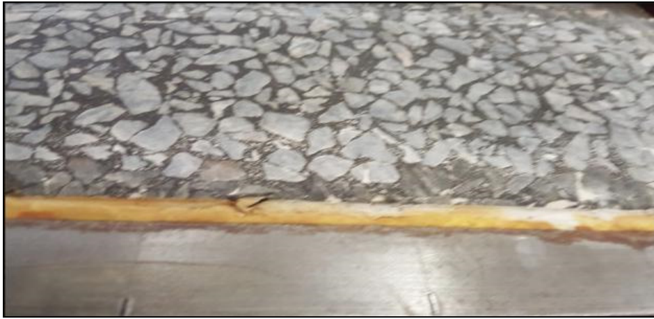
Figure 5.22 Joint de plâtre pour réduire les mouvements.
