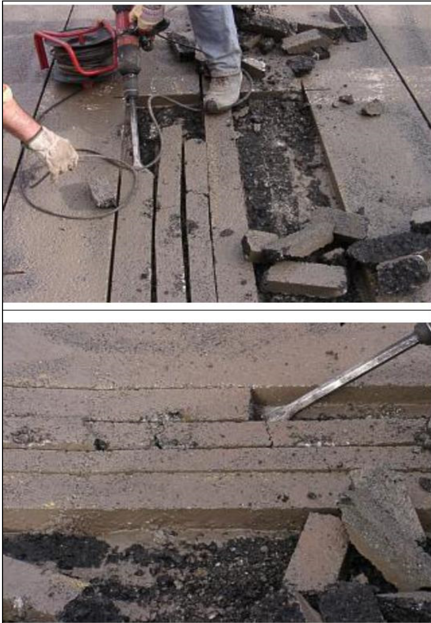
Figure 3.16 Excavation pour installer un système piézo (IRD, 2001)
