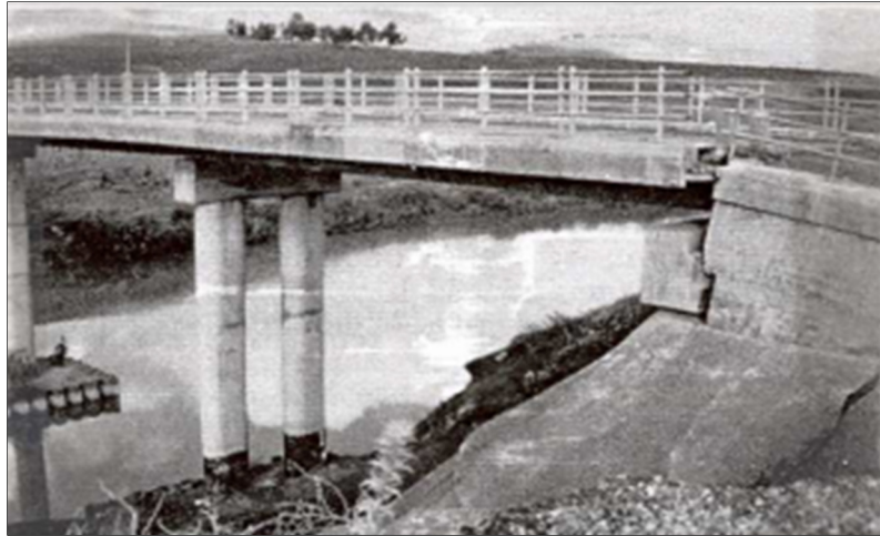
Figure 1.10 Rupture de la culée Tirée de Davidovici (1985)
