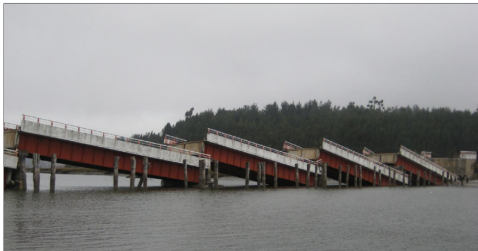
Figure 1.13 Effondrement de plusieurs travées simplement appuyées Tirée de Yashinsky et al. (2010)
