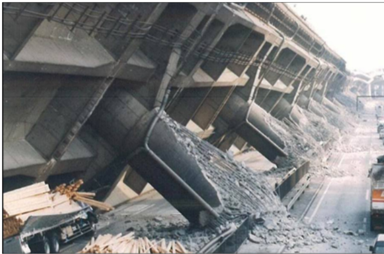
Figure 1.9 Effondrement de l'autoroute Hanshin lors du tremblement de terre de Kobe Tirée de Yashinsky et al. (2010)
