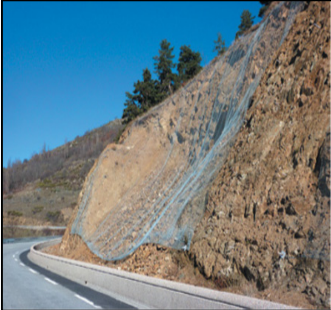
Figure 0.39 Grillage avec piège à fosse de réception Tirée d'Ansaldi et Guglielmetti (2016)
