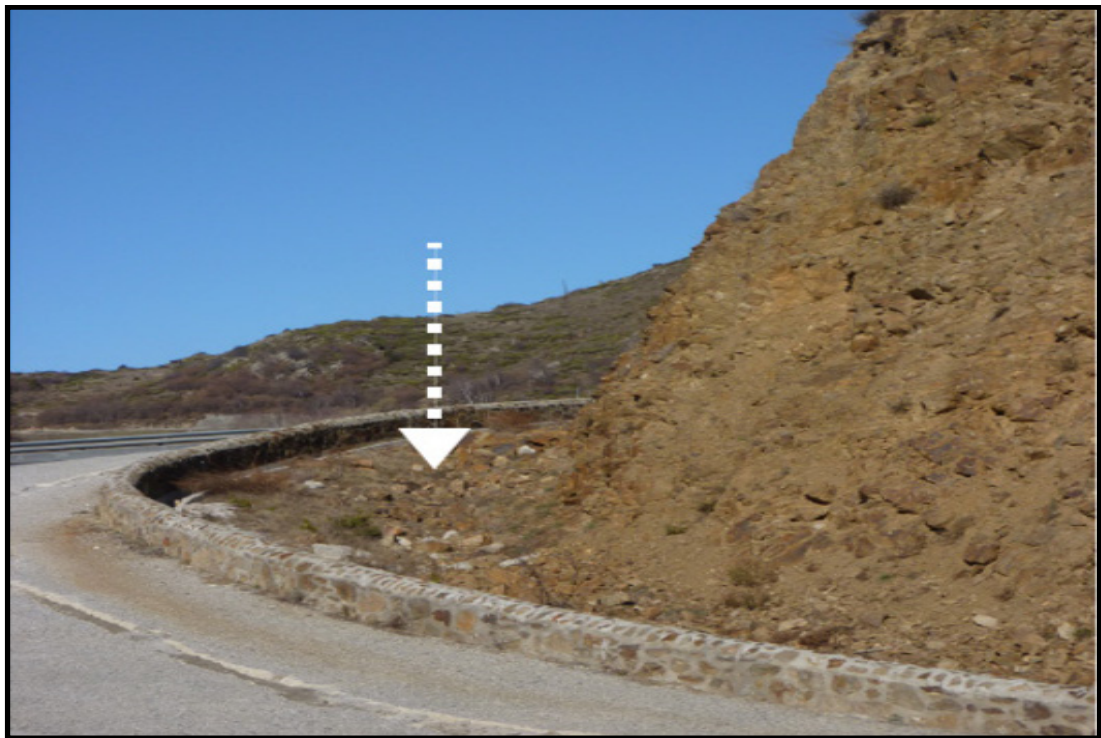
Figure 0.36 Fosse de réception aménagée en pied de falaise Tirée de Ansaldi et Guglielmetti (2016)
