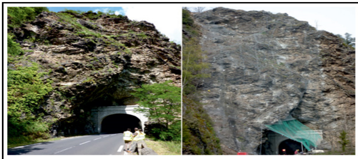
Figure 0.47 Grillage, avant et en fin de travaux Prats-de-Mollo (France) Tirée d'Ansaldi et Guglielmetti (2016)
