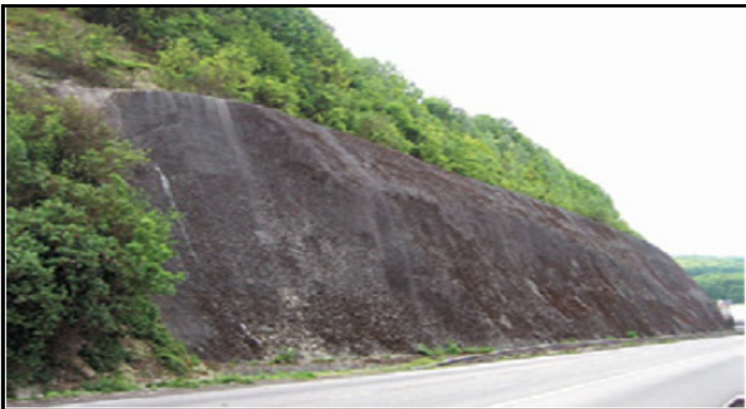
Figure 0.46 Béton projeté à Darnétal (Seine-Maritime) sur un talus routier Tirée d'Ansaldi et Guglielmetti (2016)
