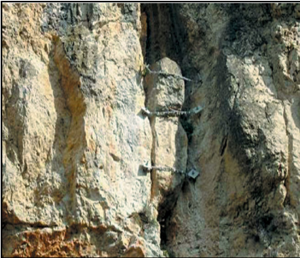
Figure 0.45 Ancrage d'emmaillotement à Rocamadour Tirée d'Ansaldo et Guglielmetti (2016)
