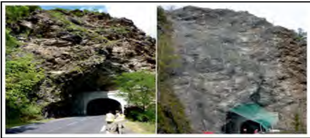
Figure 0.47 Grillage, avant et en fin de travaux Prats-de-Mollo (France) Tirée d'Ansaldo et Guglielmetti (2016)
