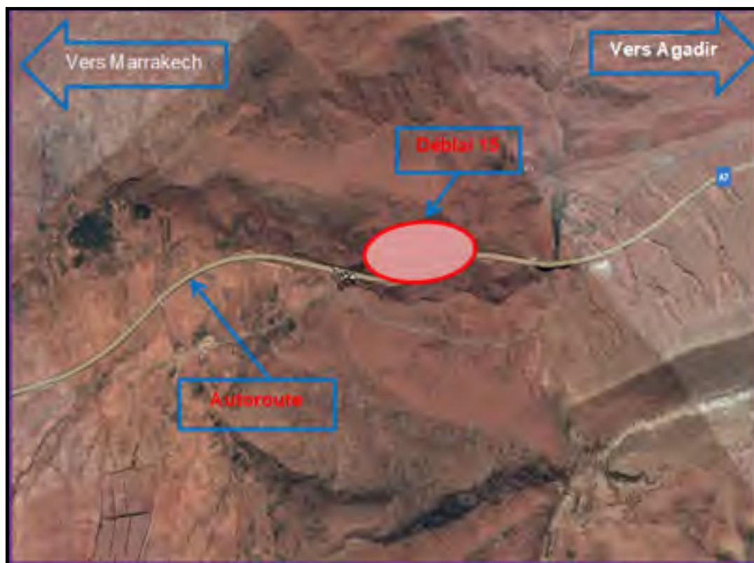
Figure 0.1 Situation du déblai D15 sur le tracé autoroutier Tirée de (Google Earth)
