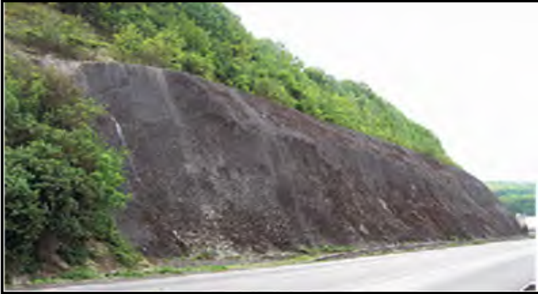
Figure 0.46 Béton projeté à Darnétal (Seine-Maritime) sur un talus routier Tirée d'Ansaldo et Guglielmetti (2016)
