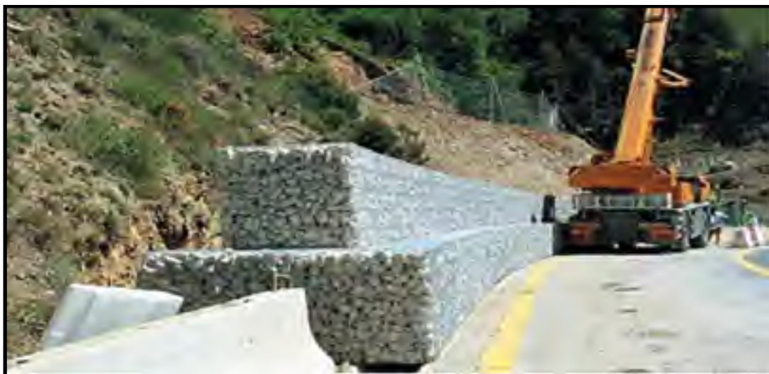
Figure 0.35 Mur de gabions Tirée d'Ansaldi et Guglielmetti (2016)
