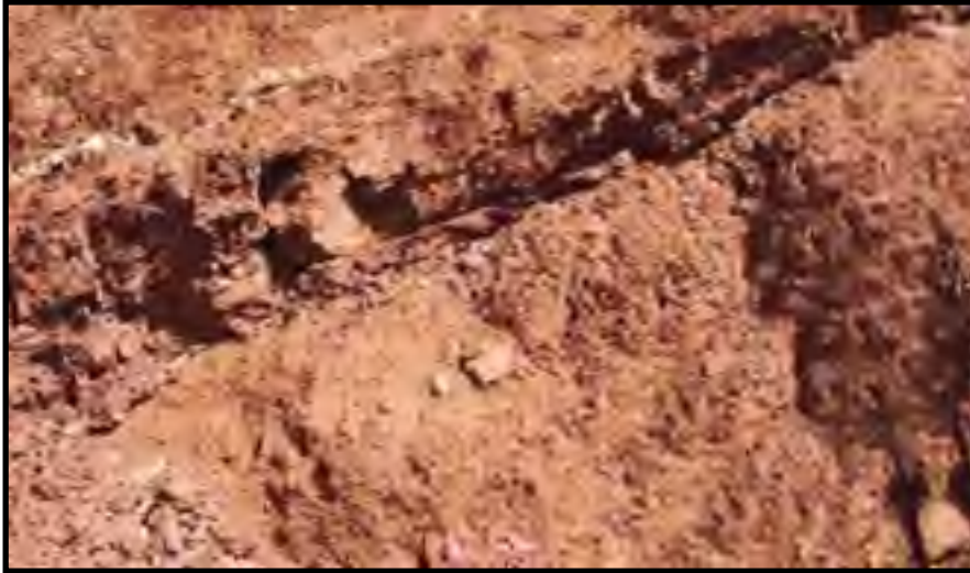
Figure 0.5 Faille sur la zone nord du déblai D15 Tirée d' Ejjaaaouani et Boujemaoui (2014)
