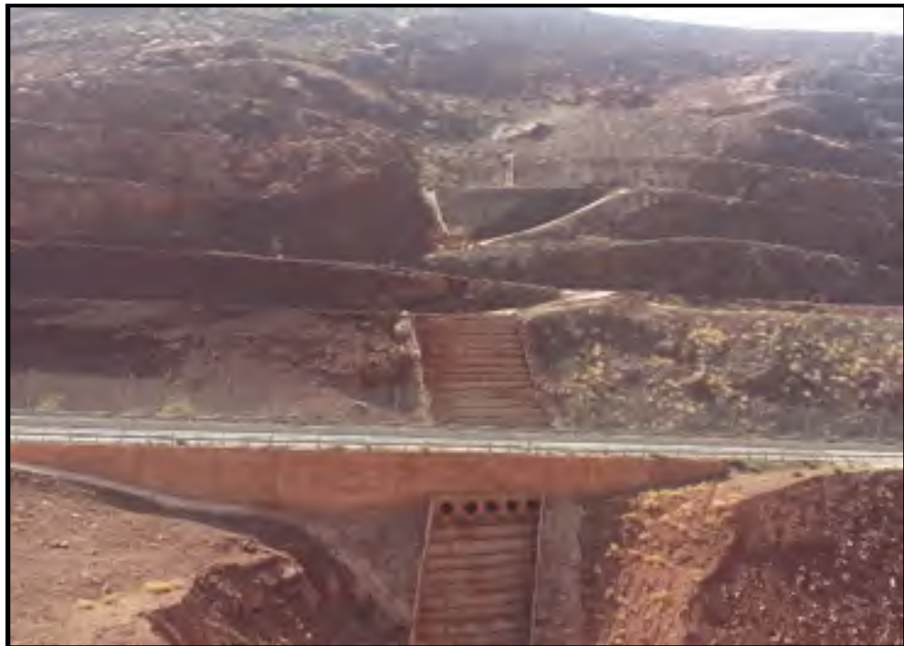
Figure 0.48 Évacuations des eaux superficielles dans le déblai D15
