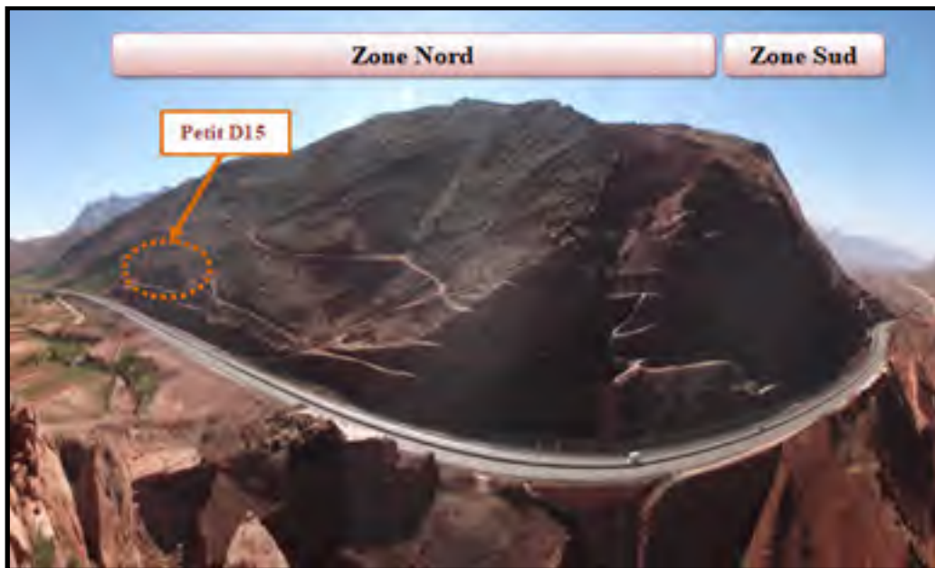
Figure 0.1 Localisation du talus «petit D15 » par rapport au déblai D15
