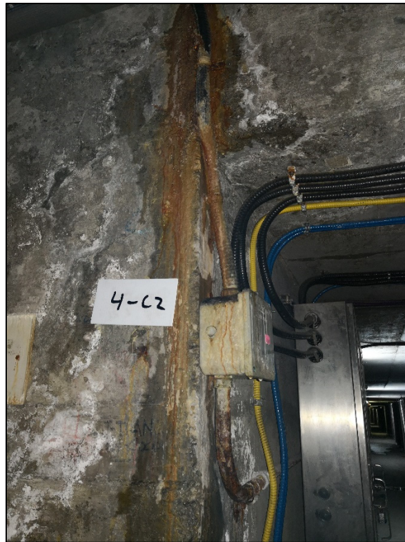
Figure 1.7 Endommagement des équipements électriques suites à des infiltrations d'eau dans un tunnel au Québec
