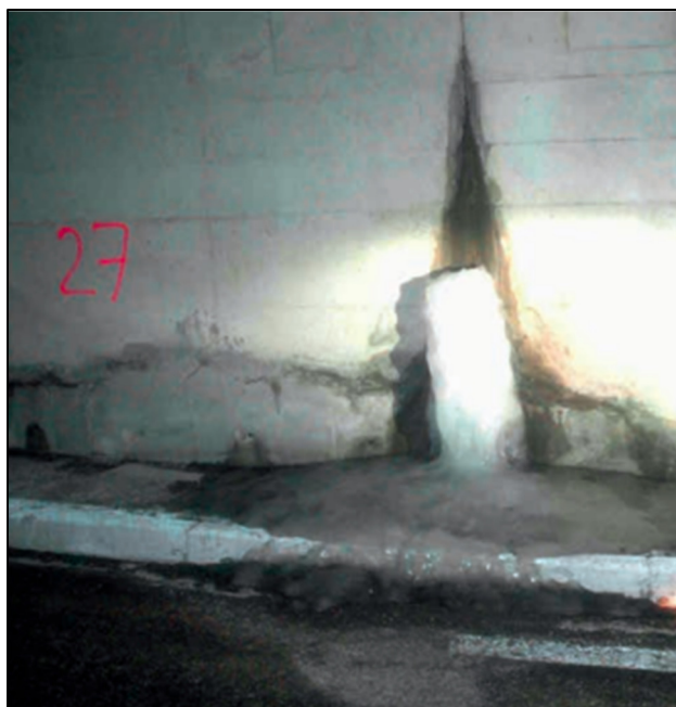
Figure 1.8 Amas de glace provenant d'un joint et formation du verglas sur le trottoir et la chaussée Tirée de CETU (2015)
