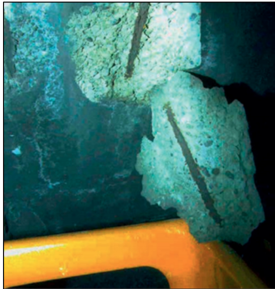
Figure 1.2 Écaillage du béton et corrosion des armatures Tirée de CETU (2015)
