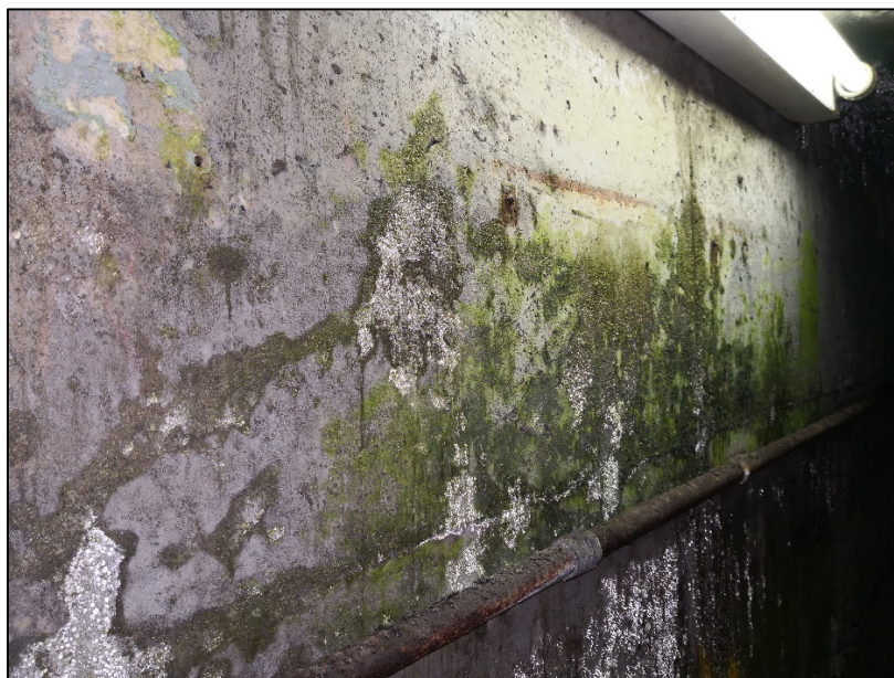
Figure 1.6 Humidité et moisissure dans un couloir de tunnel au Québec
