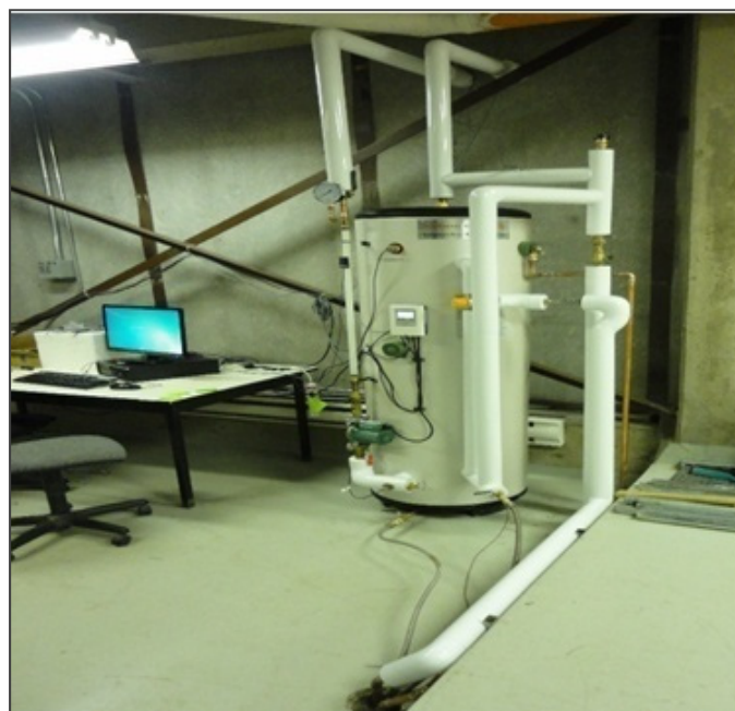
Figure 2.4 Réservoir du système autovidangeable installé dans l'HéliolAB de l'ÉTS Adaptée de Dakhli (2014)
