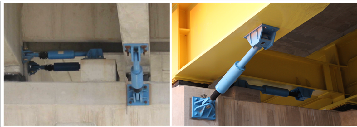
Figure 1.9 Système d'amortissement installé sur le pont Rion-Antirion, Grèce Adaptée d'Infanti et al. (2004)
