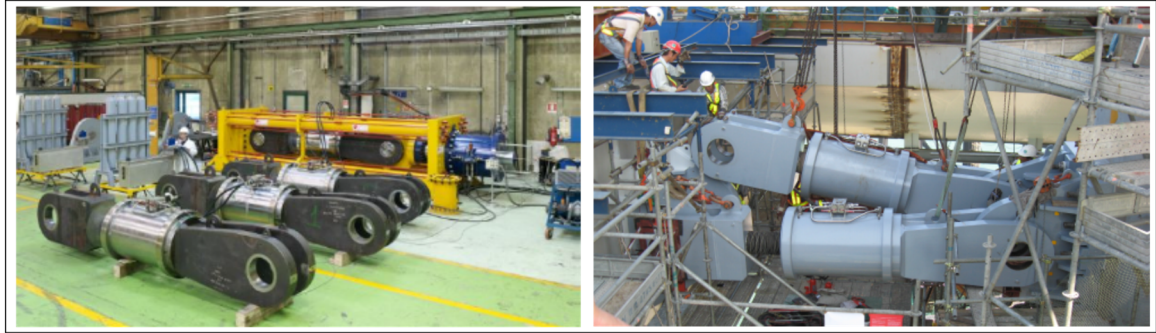
Figure 1.10 Système de transmetteurs de chocs sismiques installé pour le pont Stonecutters, Hong-Kong Adaptée de Colato et al. (2008)
