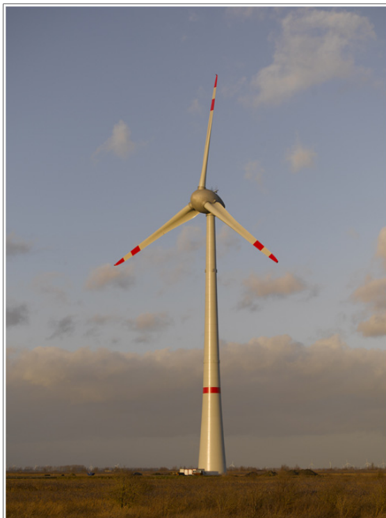
Figure 1.2 Éolienne Enercon E126, puissance nominale : 7MW, [4].
