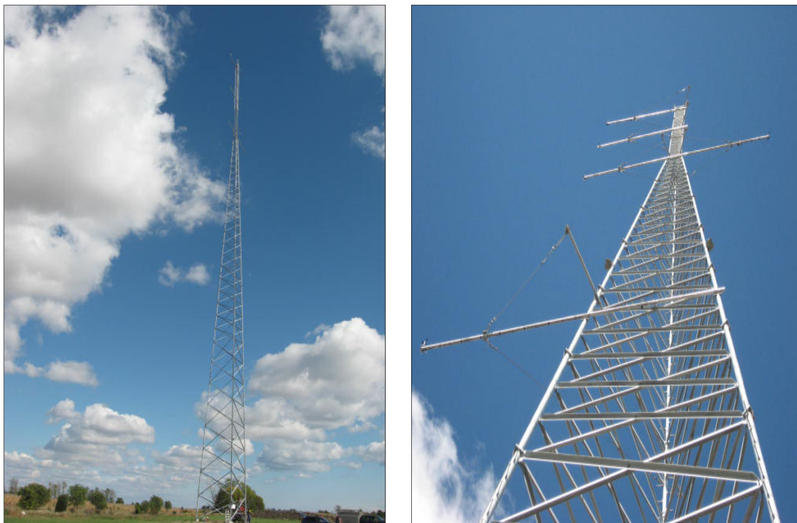
Figure 2.2 Mâts météorologique en treillis. Source : Hélimax Énergie.
