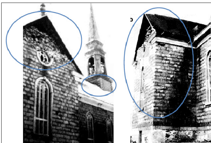
Figure 1.4 Église de Rivière-Ouelle - rupture hors-plan du pignon et fissure de cisaillement.
