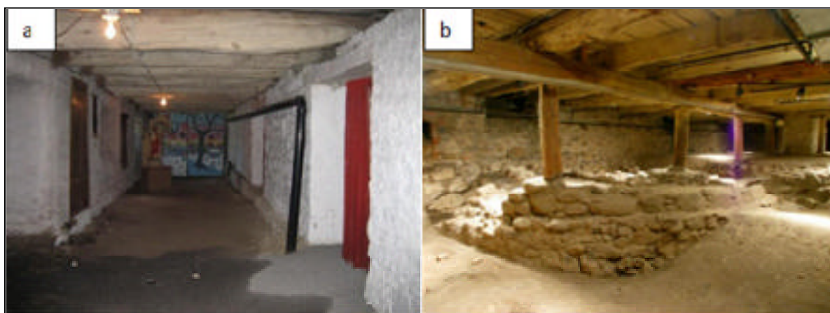
Figure 3.20 (a) Sous-sols des églises Sainte-Geneviève [95] et (b) Notre-Dame-de-Bon-Secours [26].
