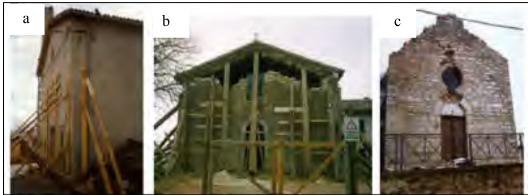
Figure 1.9 Mécanismes de rupture observés en Ombrie (Italie). Tirée de D'Ayala (2000, p. 5)
