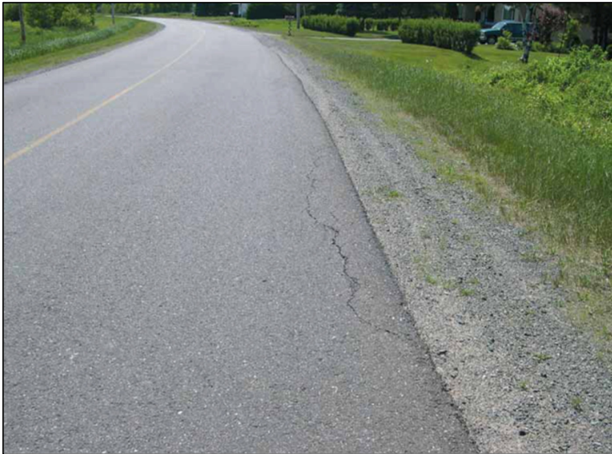
Figure 1.11 Edge cracks
