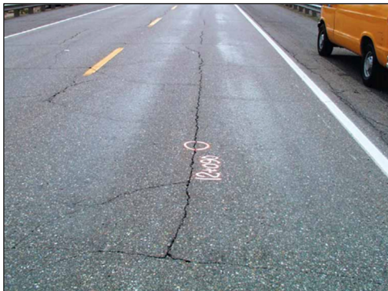
Figure 1.12 Longitudinal cracking Taken from Guide de mesure et d'identification des dégradations des chaussées souples MTQ (2007)
