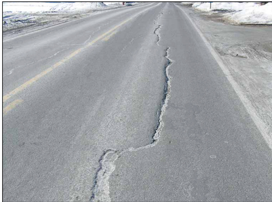
Figure 1.9 Cracking due to the effects of frost Taken from Guide de mesure et d'identification des dégradations des chaussées souples MTQ (2007)
