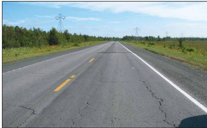
Figure 1.14 Longitudinal fatigue cracks (wheel-paths) Taken from Guide de mesure et d'identification des dégradations des chaussées souples MTQ (2007)
