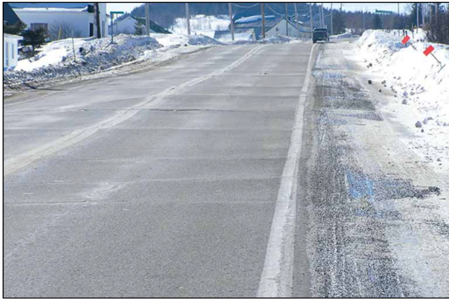
Figure 1.16 Shoving (Corrugations) Taken from Guide de mesure et d'identification des dégradations des chaussées souples MTQ (2007)
