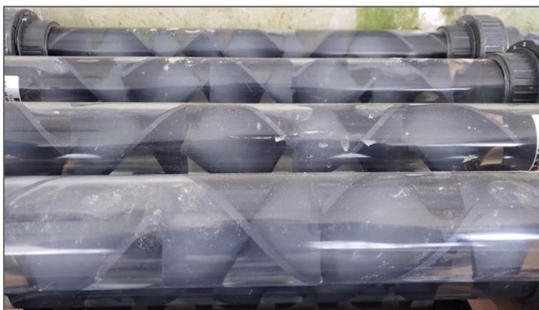
Figure 2.5 Mélangeurs statiques installés au long du système de traitement.
