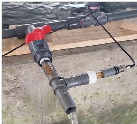
Figure 2.6 Électrode Sensorox® de POR installée sur la vanne *S-p5*
