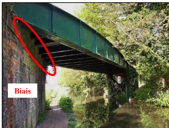
Figure 1.12 Présence d'un biais sur un pont Tirée de Anonyme (2010)
