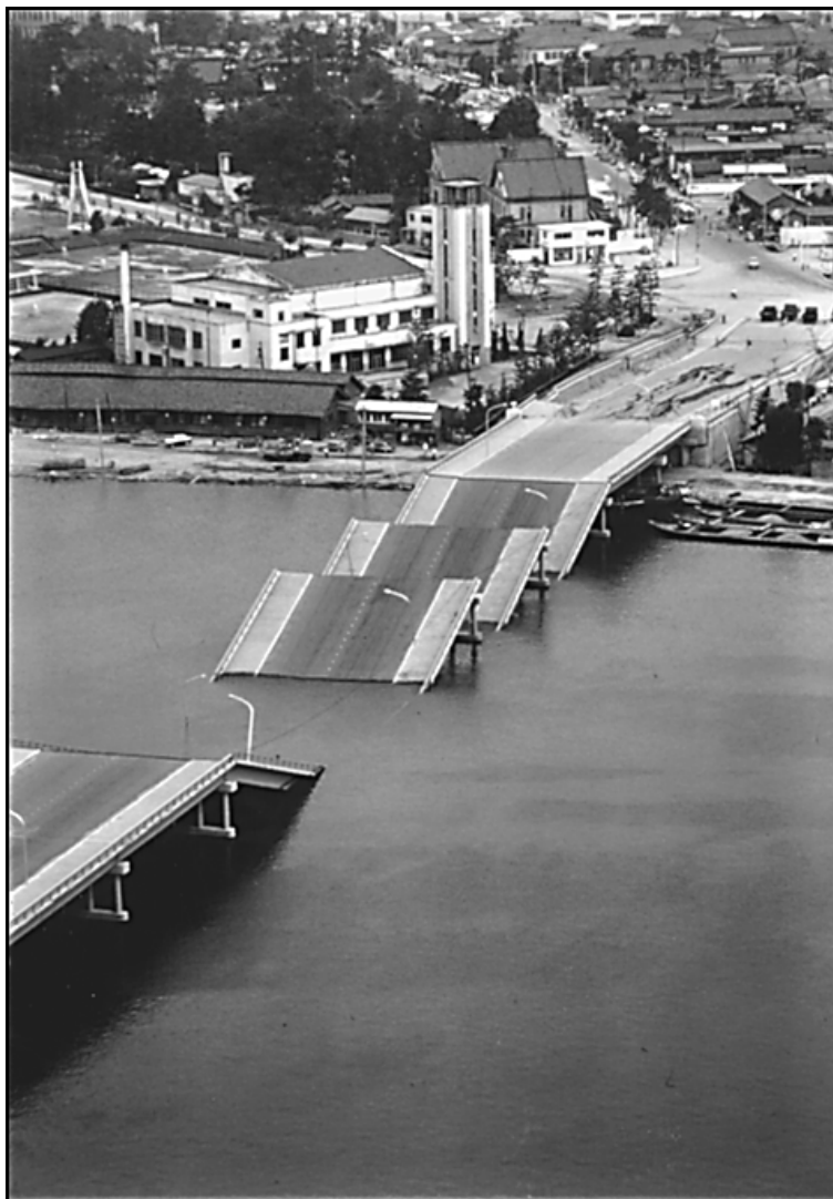
Figure 1.4 Effondrement par perte d'appui des travées simplement appuyées du pont Showa lors du séisme de Niigata en 1964 Tirée de Moehle et Eberhard (2003)
