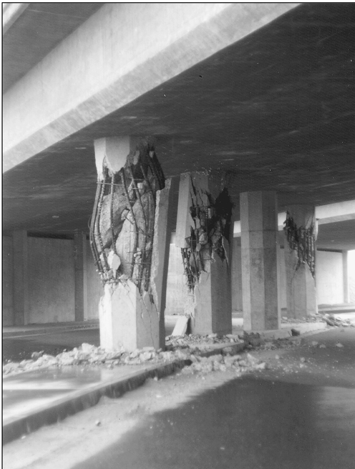
Figure-A I-6 Défaillance en cisaillement de colonnes avec faible quantité de barres d'armature transversales du viaduc de la route 5/210 lors du séisme de San Fernando en 1971 Tirée de Moehle et Eberhard (2003)
