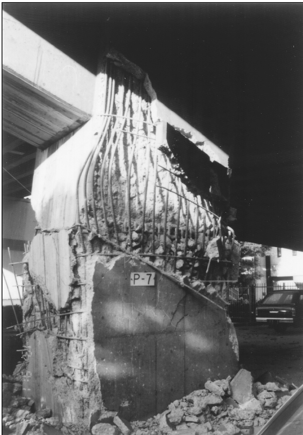
Figure-A I-7 Défaillance d'une colonne avec barres d'armature se terminant près de la mi-hauteur et avec chevauchement insuffisant lors du séisme de Hyogo-Ken Nanbu en 1995 Tirée de Moehle et Eberhard (2003)
