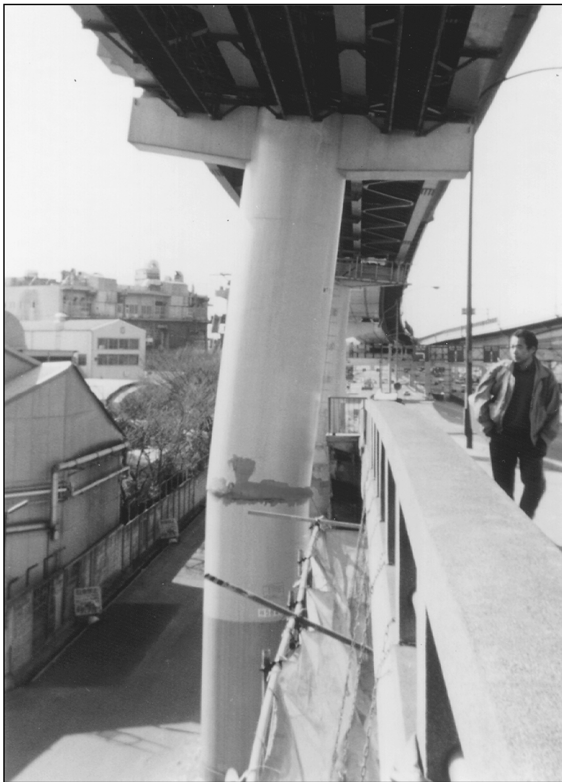
Figure-A I-8 Flambement d'une colonne en acier de l'autoroute Hanshin lors du séisme de Hyogo-Ken Nanbu en 1995 Tirée de Moehle et Eberhard (2003)
