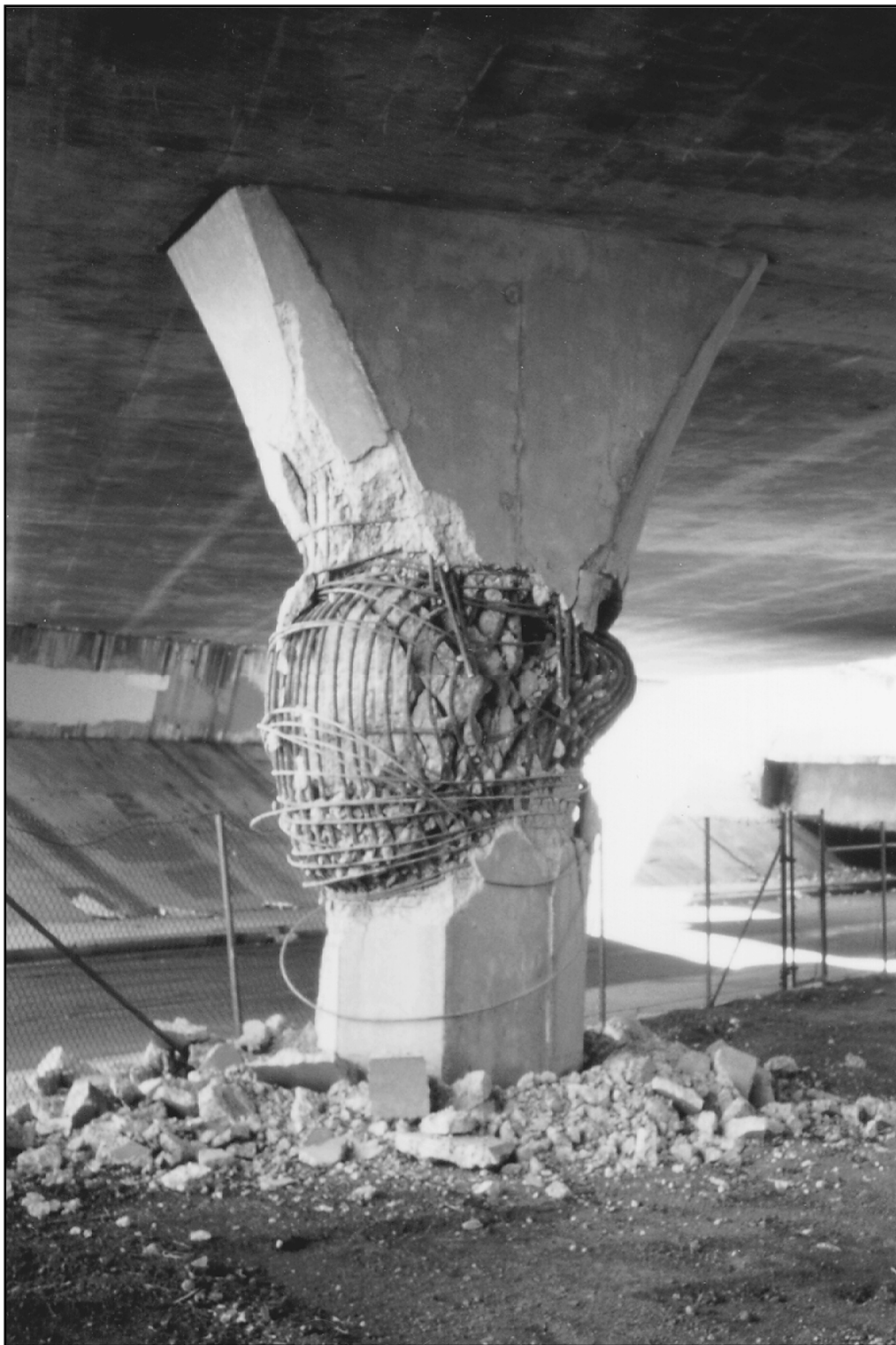
Figure-A I-11 Effet d'un élément architectural sur le viaduc Mission-Gothic de la route 118 lors du séisme de Northridge en 1994 Tirée de Moehle et Eberhard (2003)
