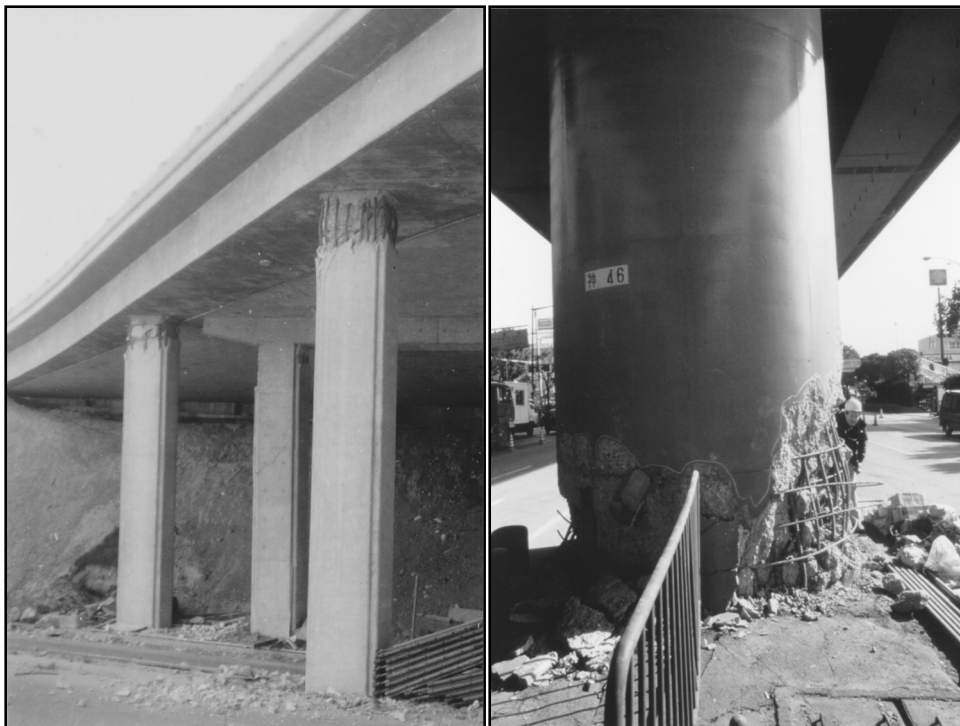
Figure-A I-5 Ductilité en flexion insuffisante pour (gauche) le viaduc de la route San Fernando lors du séisme de San Fernando en 1971 et pour (droite) l'autoroute Hanshin lors du séisme de Hyogo-Ken Nanbu en 1995 Tirée de Moehle et Eberhard (2003)
