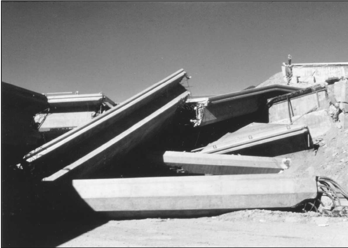
Figure-A I-9 Défaillance à la base des colonnes avec ancrage inadéquat des barres d'armature longitudinales lors du séisme de San Fernando en 1971 Tirée de Moehle et Eberhard (2003)
