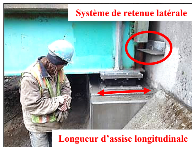
Figure 1.5 Localisation d'une longueur d'assise et du système de retenue sur un pont Tirée de Bohmer Construction (2012)
