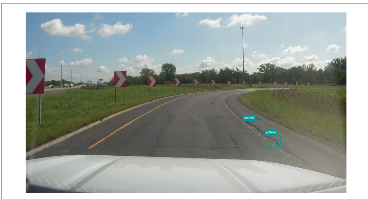
Figure 4.12 Exemple d'annotation où deux nids de poule sont identifiés
