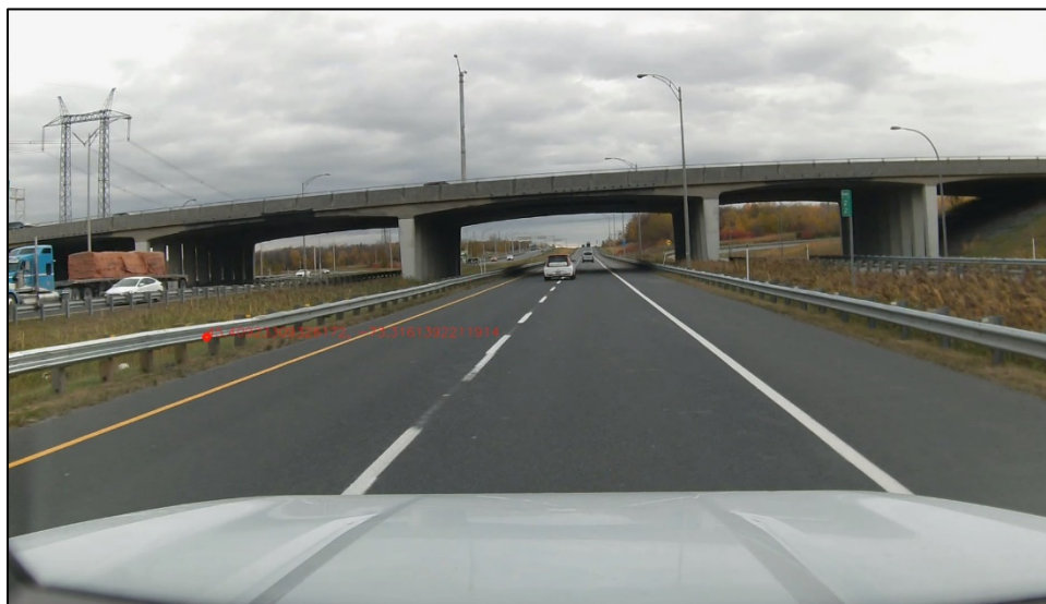
Figure 3.18 Pointeur sur barrière réparée
