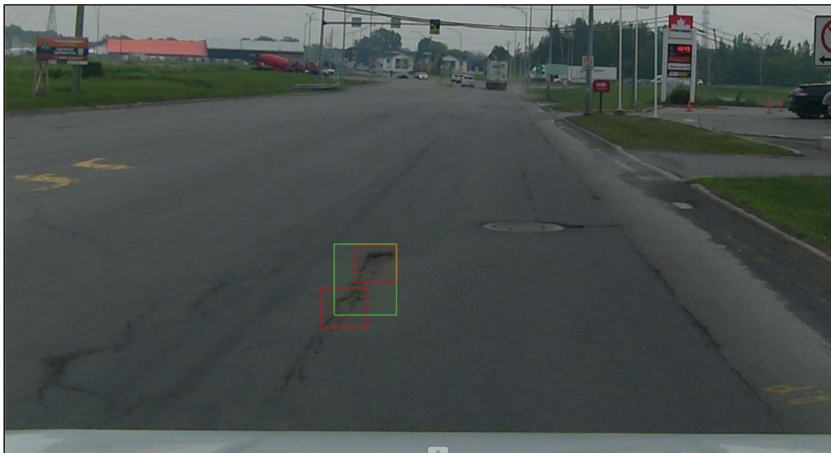
Figure 4.11 Exemple de détection de nids de poule (prédiction du modèle en rouge et notre annotation en vert)
