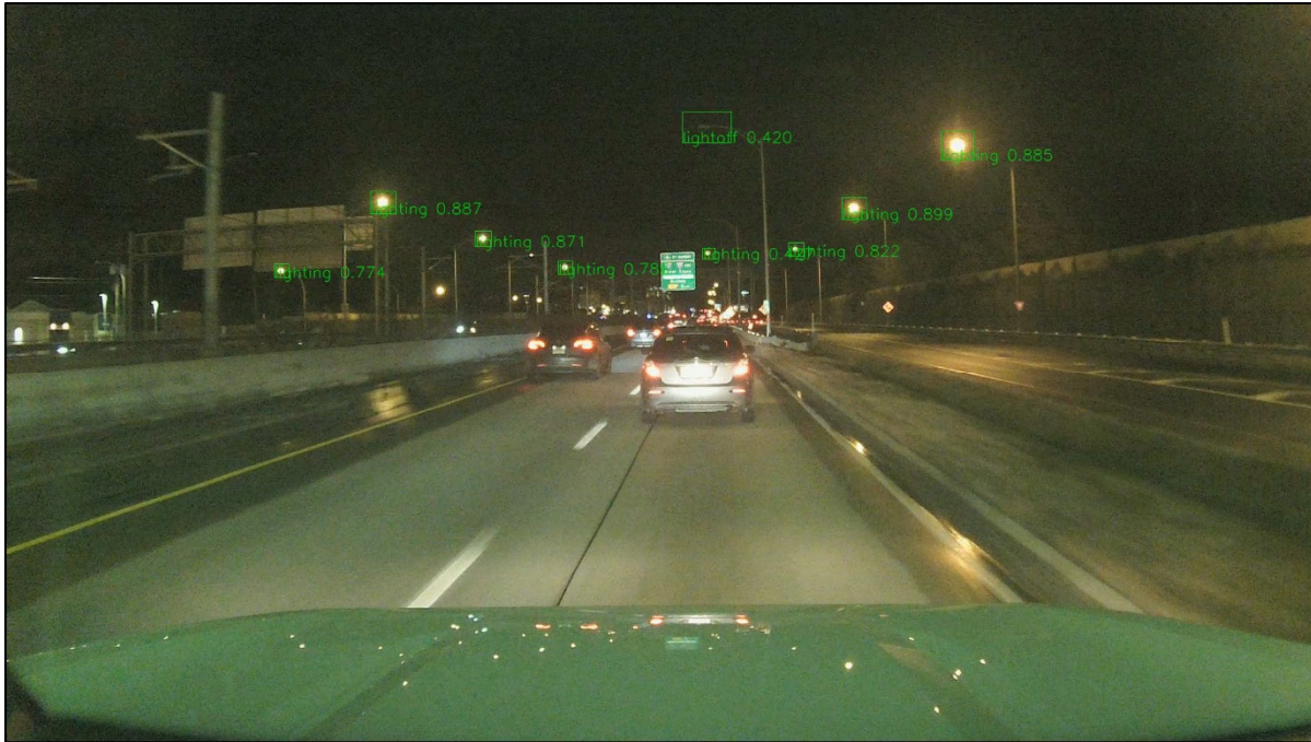
Figure 2.4 Cliché pris par le déclenchement du modèle de détection de lampadaires brisés
