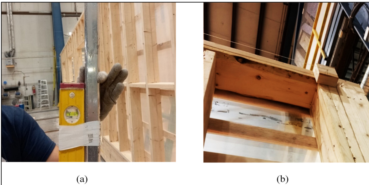
Figure 1.3 Système de contrôle du parallélisme de deux côtés opposés des modules
