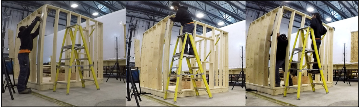
Figure 5.3 Déroulement de test en usine
