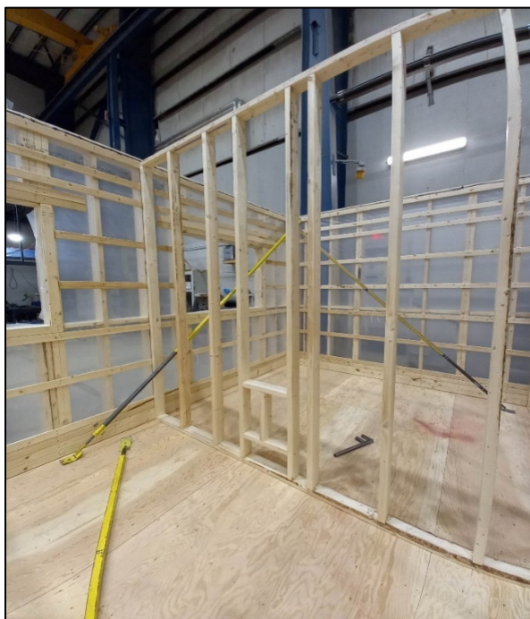
Figure 1.2 Supports muraux ajustables utilisés pour l'assemblage des murs
