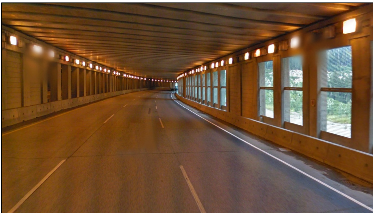
Figure 4.5 Pare-avalanches avec voie auxiliaire pour véhicules lents sur la route 5 (Colombie-Britannique) Adaptée de Google Inc. (2019c)
