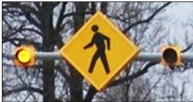
Figure 2.20 Feux clignotants renforçant le message d'un panneau Adaptée de Vanasse Hangen Brustlin, Inc. (s.d.), cité par ITE (2015)
