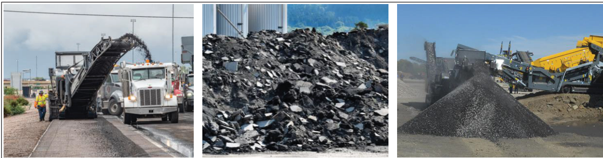
Figure 1.14 Fabrication des GBR
