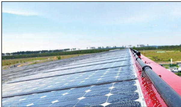
Figure 1.10 Système d'aspersion d'eau sur un collecteur PV Tirée de Sunbooster (2018)
