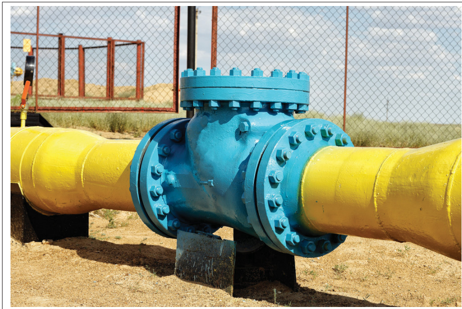
Figure 1.1 Exemple de montage d'assemblage à brides boulonnées, ici de grande taille et de type bride à collerette à droite et à gauche et pleine sur le dessus
