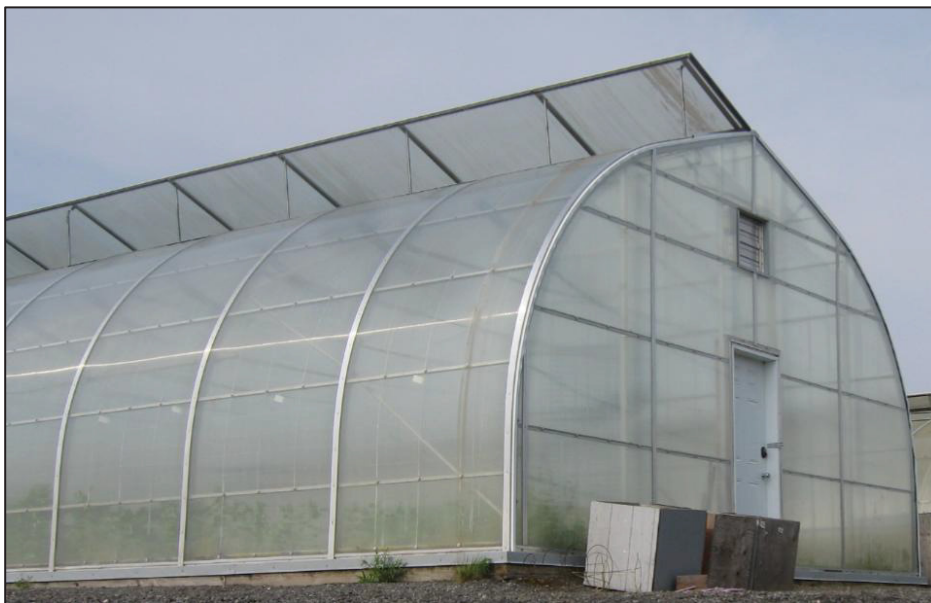
Figure 1.8 Toit ouvrant d'une serre à Kuujjuaq Adapté de Piché (2021)
