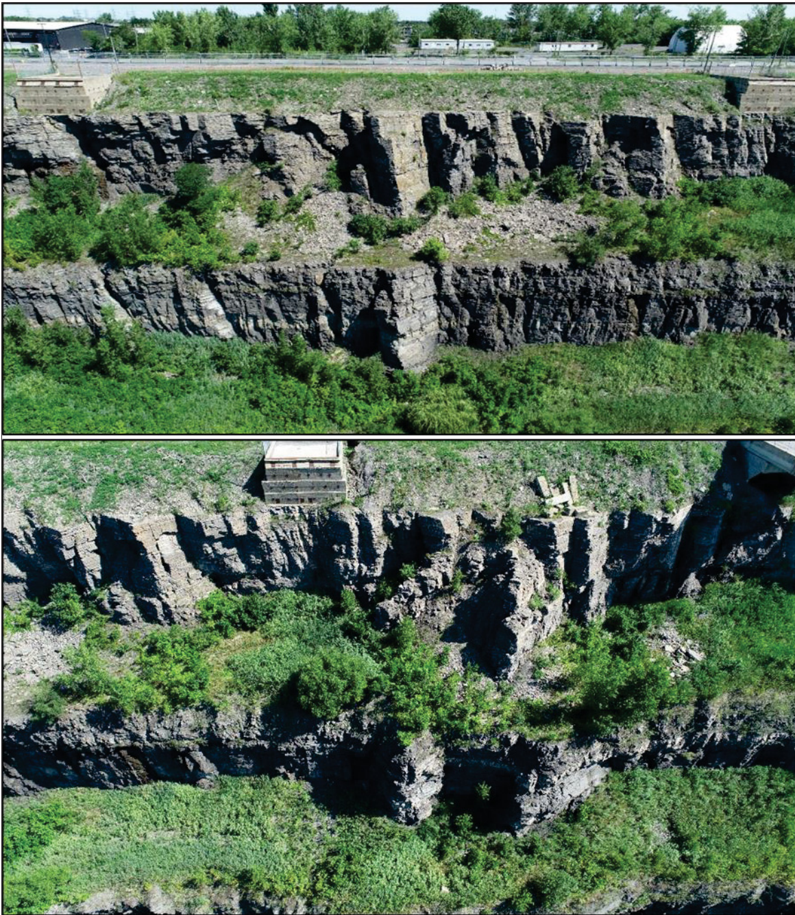
Figure 3.16 Segmentation structurale du massif rocheux dans la carrière Francon. Les vues montrent l'interaction entre la stratification subhorizontale et les familles de joints subverticaux, qui délimitent des blocs rocheux de géométrie variable
