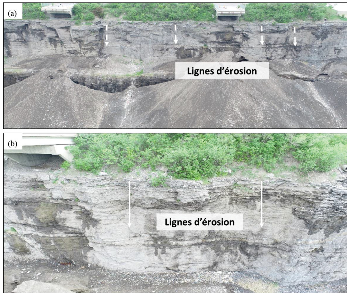
Figure 3.28 Exemples de lignes d'érosion observées sur les parois de la carrière Francon. (a) Vue d'ensemble montrant plusieurs traces de ruissellement sous les zones de déversement. (b) Vue rapprochée illustrant des marques d'érosion sur la face rocheuse. Ces formes indiquent des trajectoires préférentielles d'écoulement susceptibles de favoriser le lessivage et l'altération superficiel
