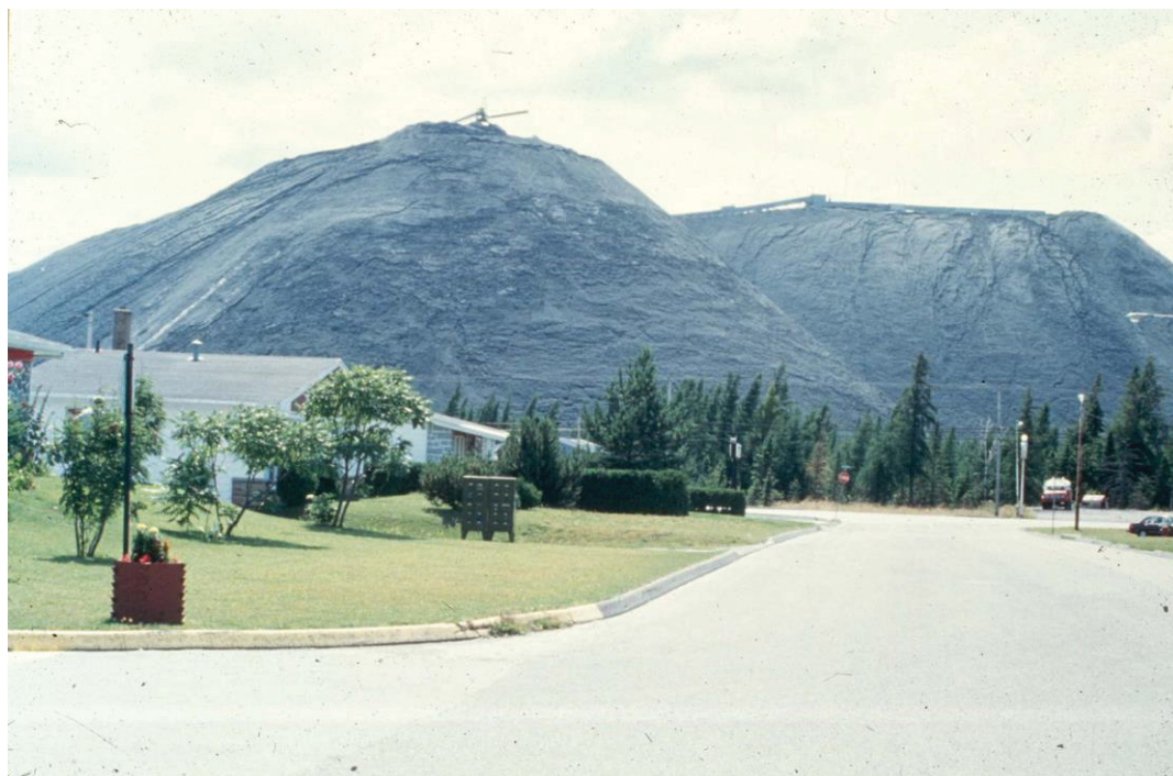
Figure 2.1 Empilement de remblais granulaires à proximité d'un milieu urbain (Aubertin, 2025)
