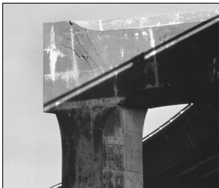
Figure 1.21 Fissuration au niveau de l'encastrement entre une poutre et une colonne. (Tiré de Chen et Duan, 2003)
