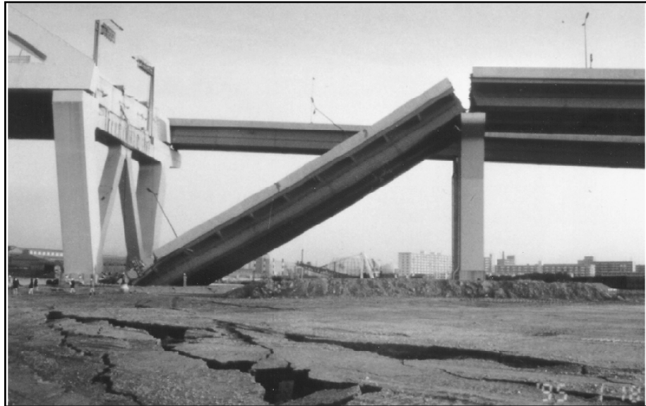
Figure 1.22 Échappement d'une travée lors du séisme de 1995 à Kobe. (Tiré de Chen et Duan, 2003)
