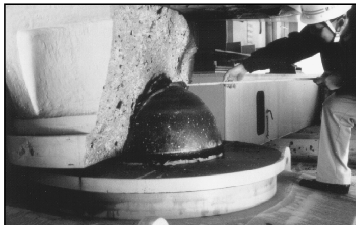
Figure 1.23 Rupture d'un appui lors du tremblement de terre de Kobe en 1995. (Tiré de Chen et Duan, 2003)
