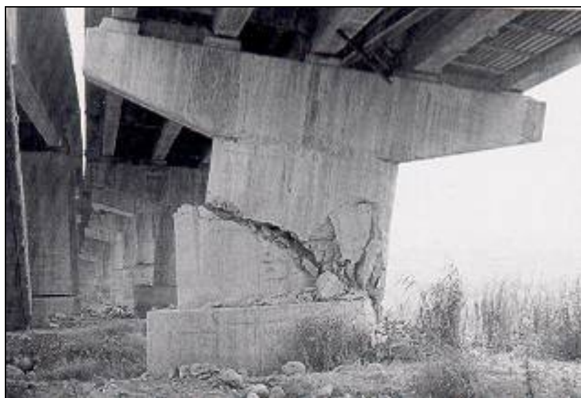
Figure 2.11 Rupture des piles par cisaillement. Tirée de Tiré de CTOA (1999)
