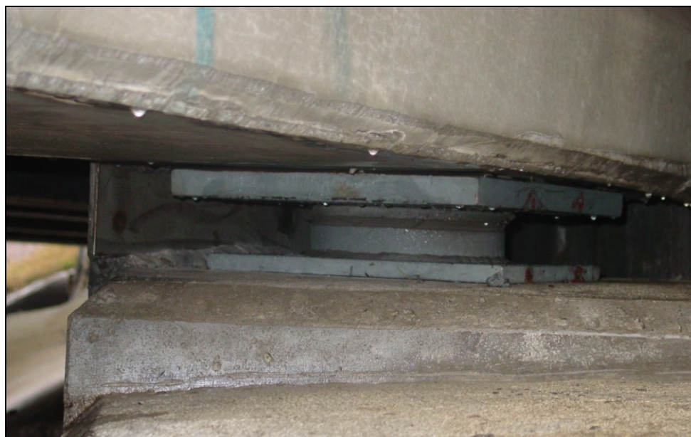
Figure 2.19 Appareils d'appuis en élastomère.
