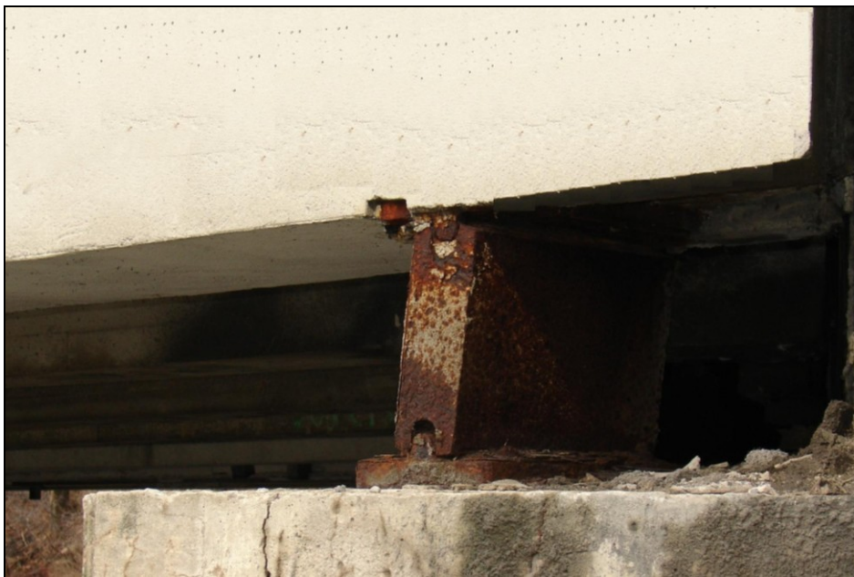
Figure 2.18 Appareils d'appuis à pendules.
