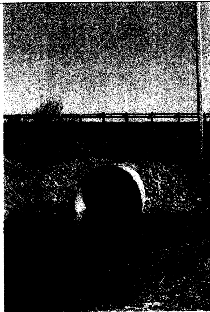
Photo n° 5 Ponceau n° 63, rang Lepage, côté sud
