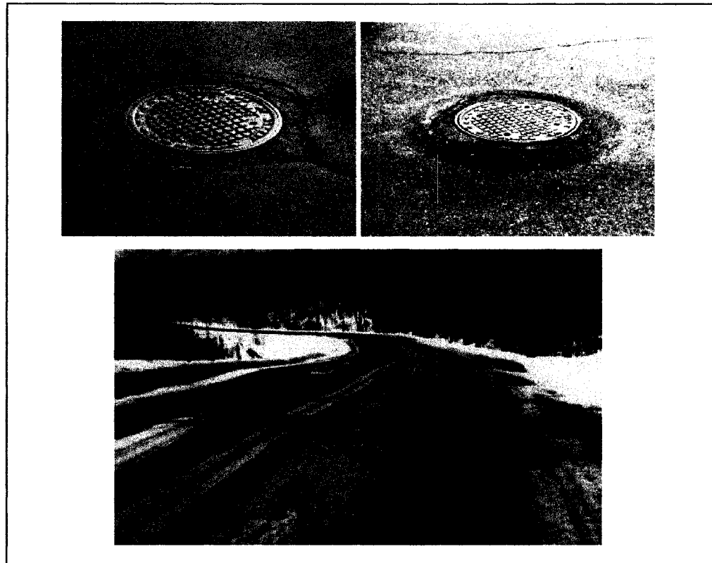
Figure 2.8 Fissuration autour d'un accès, dénivellation autour d'un accès et bosse ou soulèvement différentiel. (MTQ, 2002)
