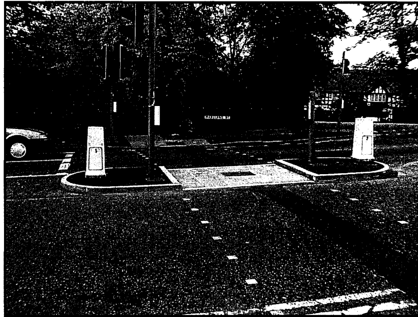
Figure 24 Refuge pour piétons à une intersection en Angleterre
