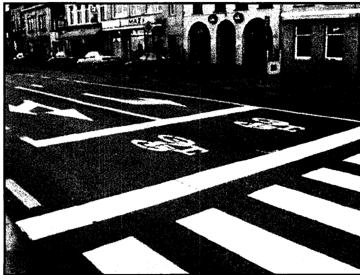
Figure 36 Zone avancée pour cyclistes ou sas pour vélos en Belgique
