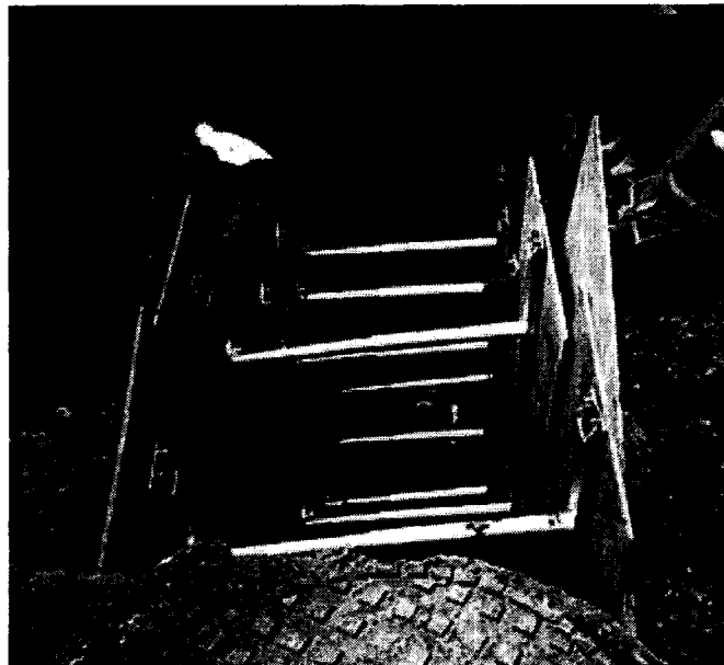
(a) Vue de l'intérieur de l'étaçonnement avec les vérins hydrauliques
