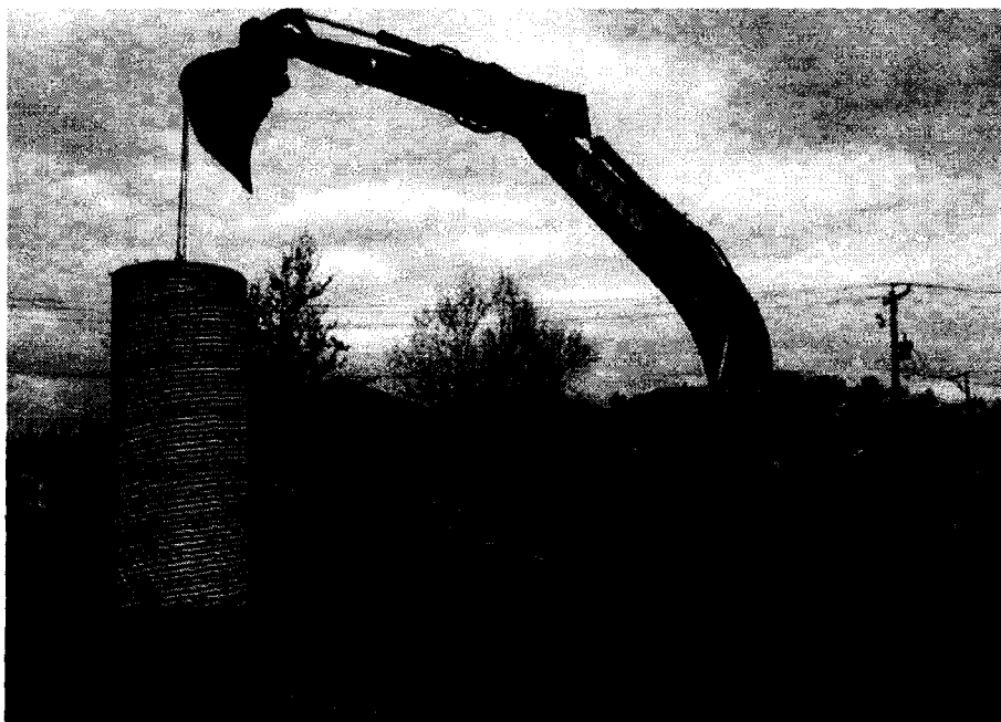
Figure 3.5 Manutention à l'aide d'une pelle rétro-excavatrice
