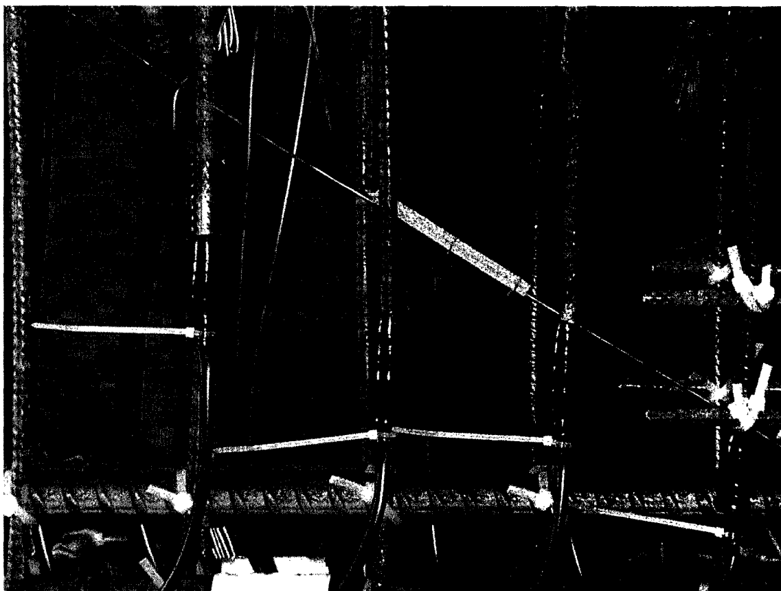
Figure 4-3 Jauge interne de déformation du béton
