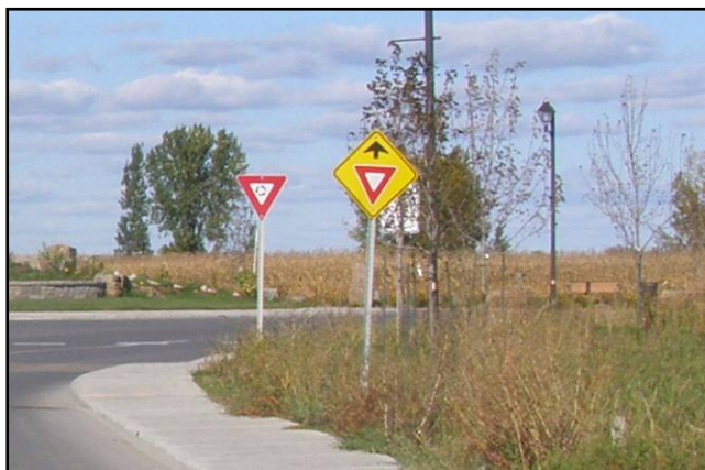
Figure 3.71 Panneau de présignalisation non nécessaire, giratoire de Repentigny (2007).
