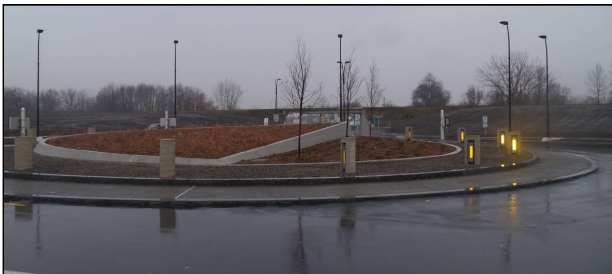
Figure 3.23 Éclairage de l'îlot central, giratoire du bout-de-l'île de Montréal (2006).
