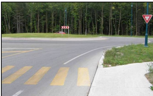
Figure-A XXVII-10 Omission du marquage de la ligne de « Cédez le passage » 1, giratoire de Mascouche (2008).
