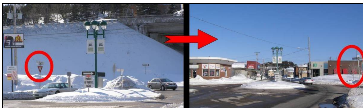
Figure 3.88 Panneau mal positionné, giratoire de Chicoutimi Nord. Tirée de Beaupré et St-Jacques (2008)
