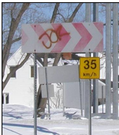
Figure 3.84 Pellicule de panneau défraîchie avec graffiti, giratoire d'Arvida (2008).
