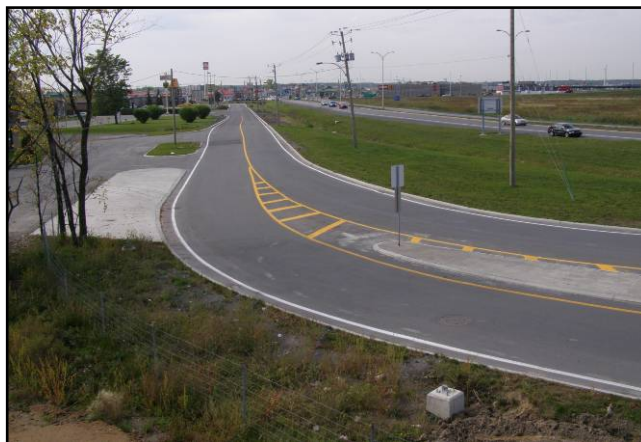
Figure-A XXVIII-2 Marquage du chevron de l'îlot séparateur de voies 2, giratoire de Vaudreuil-Dorion (2007).
