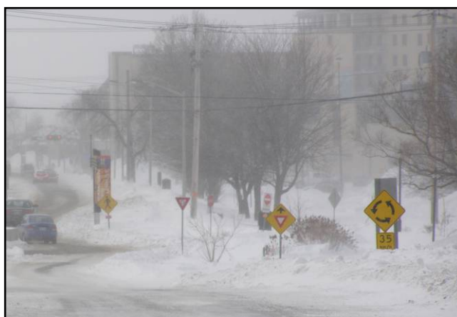
Figure 3.72 Panneau de présignalisation non nécessaire, giratoire de Chicoutimi 1 (2008).
