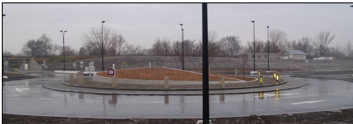
Figure 3.10 Chaussée annulaire de largeur variable, giratoire du bout-de-l'île de Montréal (2008).
