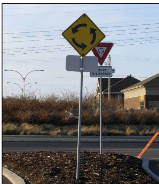
Figure-A XVIII-7 Mauvaise localisation du panneau « Intersection », giratoire de Chambly 1 (2008).
