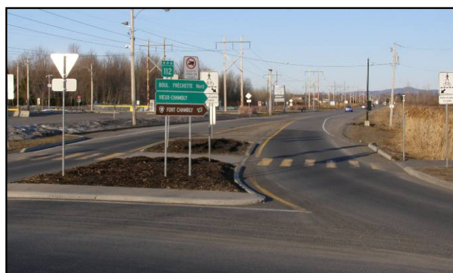
Figure 3.58 Panneau de signalisation de direction installé sur l'îlot séparateur de voies, giratoire de Chambly 2 (2008).
