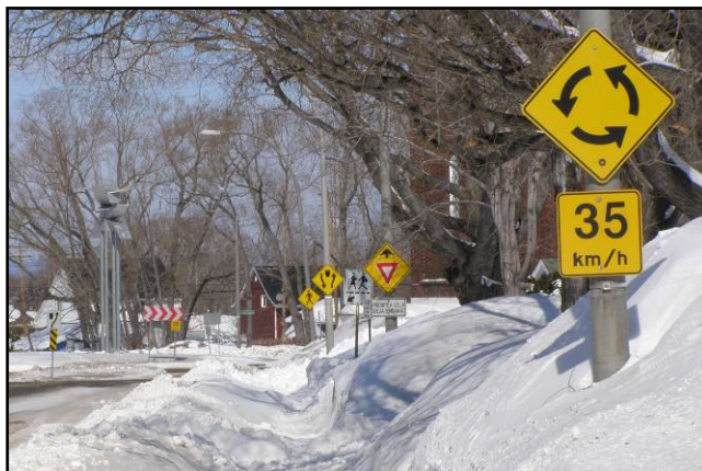
Figure 3.73 Surabondance de signalisation, giratoire d'Arvida (2008).
