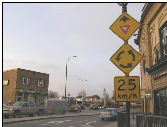
Figure 3.70 Deux panneaux de présignalisation sur un même poteau, giratoire de Gatineau 1 (2008).
