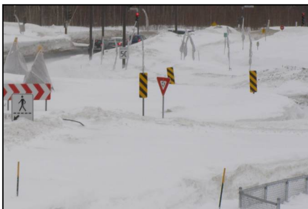
Figure 3.45 Panneau « Balise de danger » D-290-D, giratoire de Lebourgneuf (2008).
