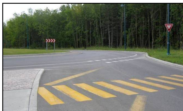
Figure-A XXVII-11 Omission du marquage de la ligne de « Cédez le passage » 2, giratoire de Mascouche (2008).
