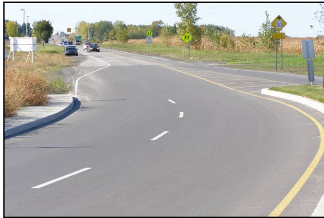
Figure 3.66 Marquage d'une ligne de délimitation de voies, d'un chevron et de lignes de rive, giratoire de Repentigny (2007).
