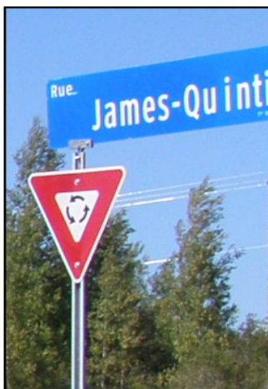
Figure 3.25 Panneau « Cédez le passage à un carrefour giratoire » de petite dimension, giratoire de Fleurimont (2007).
