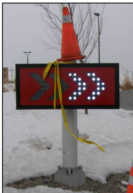
Figure 3.86 Panneau lumineux dysfonctionnel, giratoire du bout-de-l'île de Montréal (2008).
