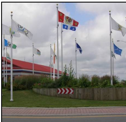
Figure 3.48 Problème de visibilité du panneau « Chevrons d'alignement dans un carrefour giratoire », giratoire de Yamachiche (2008).
