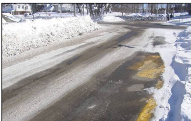
Figure 3.77 Atténuation du marquage, giratoire d'Arvida (2008).
