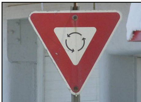
Figure 3.30 Symbole de flèches inapproprié, giratoire de Chicoutimi Nord (2008).
