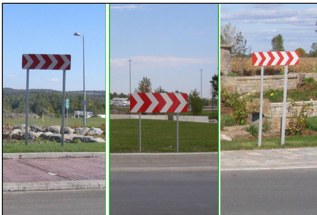
Figure 3.47 Non-uniformité de la hauteur des panneaux « Chevrons d'alignement dans un carrefour giratoire » 19 . Tirée de Beaupré et St-Jacques (2008)
