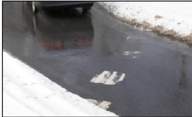
Figure 3.78 Atténuation du marquage, giratoire de l'Île-des-Sœurs 1 (2008).
