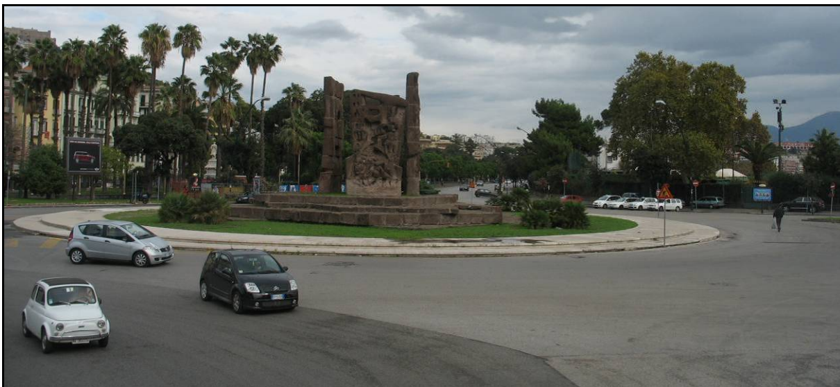
Figure 1.25 Exemple de chaussée annulaire d'un carrefour giratoire sans marquage à Naples en Italie. Photographie : Bourque (2008)
