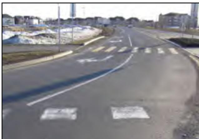
Figure-A XXV-6 Marquage de flèches de direction en approche 6, giratoire de Chambly 2 (2008).
