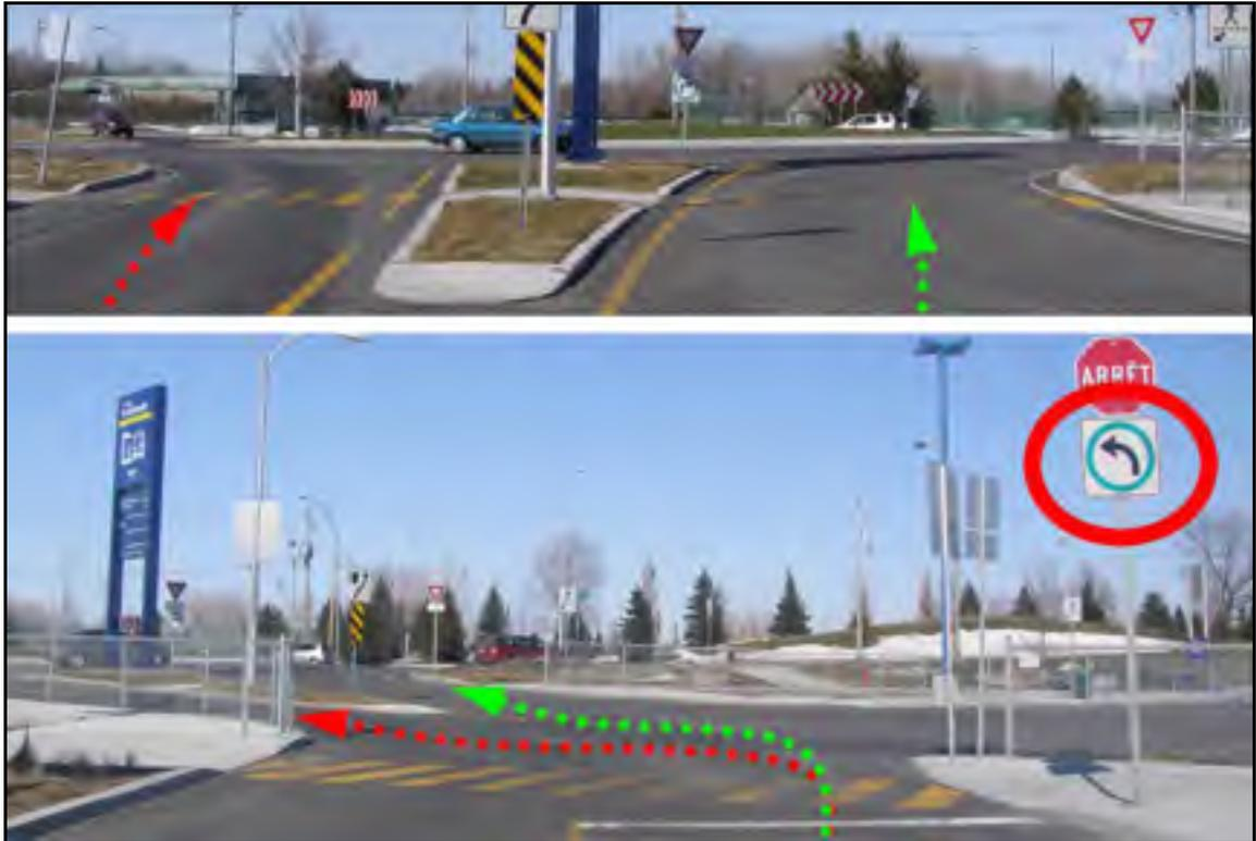
Figure 3.79 Mauvaise position du panneau « Obligation de tourner à gauche », giratoire de Boucherville.
