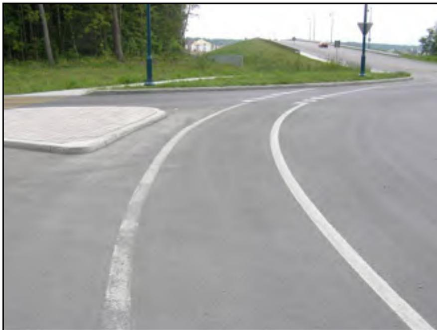
Figure 3.6 Bande cyclable sur chaussée annulaire, giratoire de Mascouche (2008).
