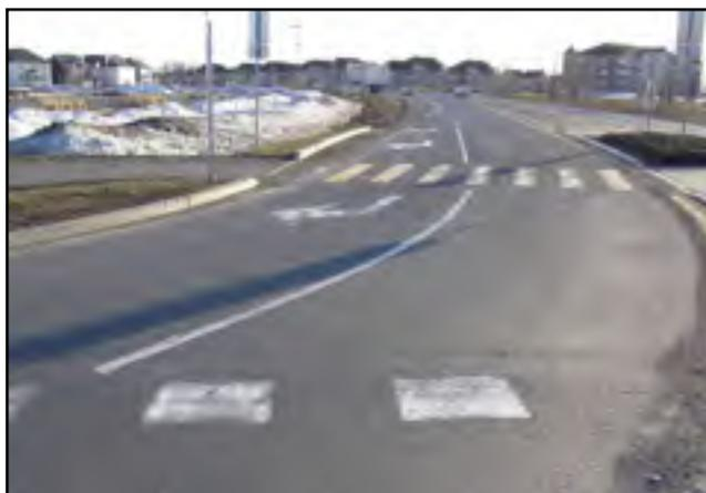
Figure 3.62 Flèches de sélection de voies, giratoire de Chambly 2 (2008).
