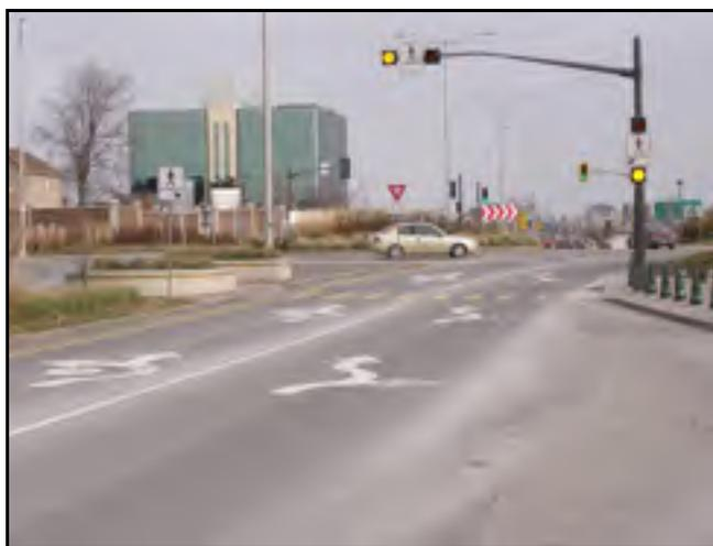
Figure 3.63 Flèches de sélection de voies, giratoire de Gatineau 2 (2008).
