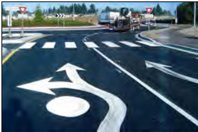
Figure 1.24 Exemple d'application du marquage de flèche de sélection de voies au Canada.
