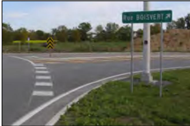
Figure 3.57 Panneau de signalisation de direction installé en périphérie, giratoire de Vaudreuil-Dorion (2007).
