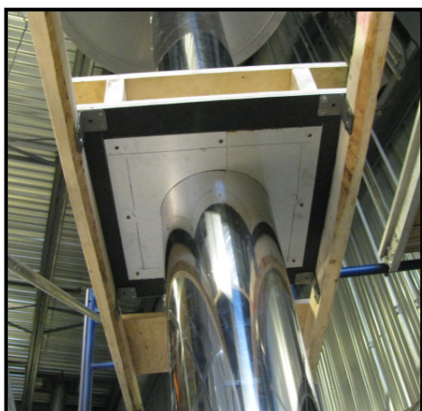
Assemblage des planchers avec la cheminée
