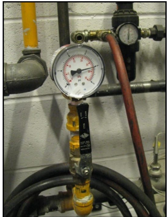
Capteur de pression du gaz
