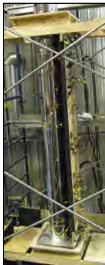
Mur avant assemblé aux planchers
