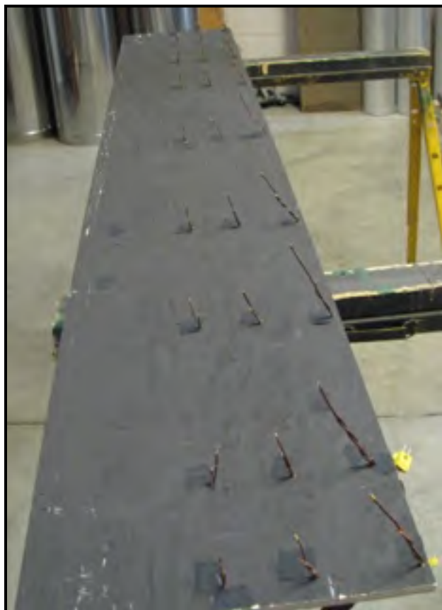
Construction du mur avant (les thermocouples sont placés pour suivre la géométrie circulaire de la conduite)
