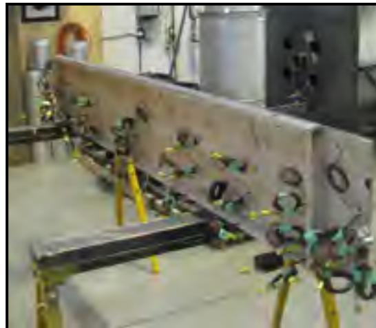
Construction du mur avant
