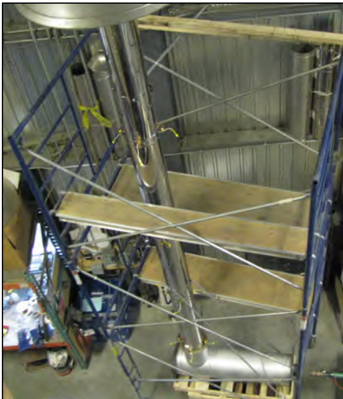
Installation des 4 sections de 4 pieds de cheminée Excel
