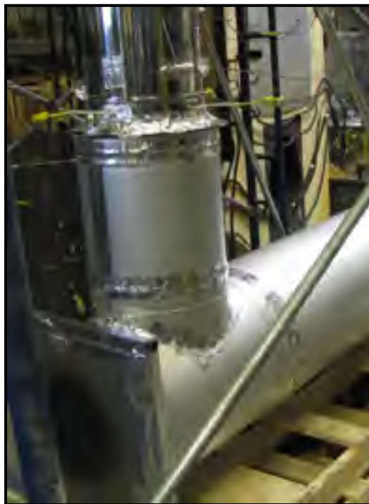
Colmatage des fuites d'air possibles au générateur et à la cheminée
