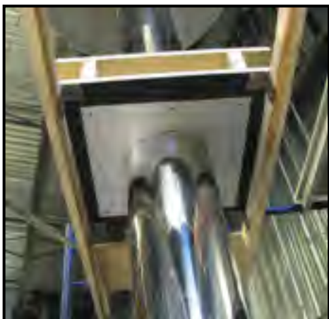
Assemblage des planchers avec la cheminée
